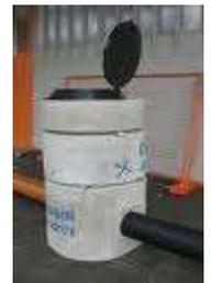
Inizialmente l'area operativa all'intorno deve essere stata già predisposta, il sistema per le emergenze attivato, ed avviato l'impianto per l'aspirazione dei vapori. Il sollevamento del chiusino può avvenire manualmente con l'ausilio di attrezzature e/o con macchine. E' obbligatoria la presenza di un sovrintendente i lavori, il che definisce anche che la composizione minima della squadra operativa deve essere di tre persone, di cui due addetti alle operazioni subordinate.
