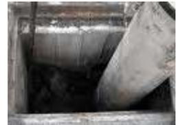
Sotto aspirazione costante dei vapori l'operatore, con un ausilio di scala e assistito all'esterno, si cala all'interno del pozzetto ed effettua l'asportazione manuale (con idonea attrezzatura) della fanghiglia residua. Alla fine si effettua lo scollegamento delle tubazioni, previa loro bonifica.
