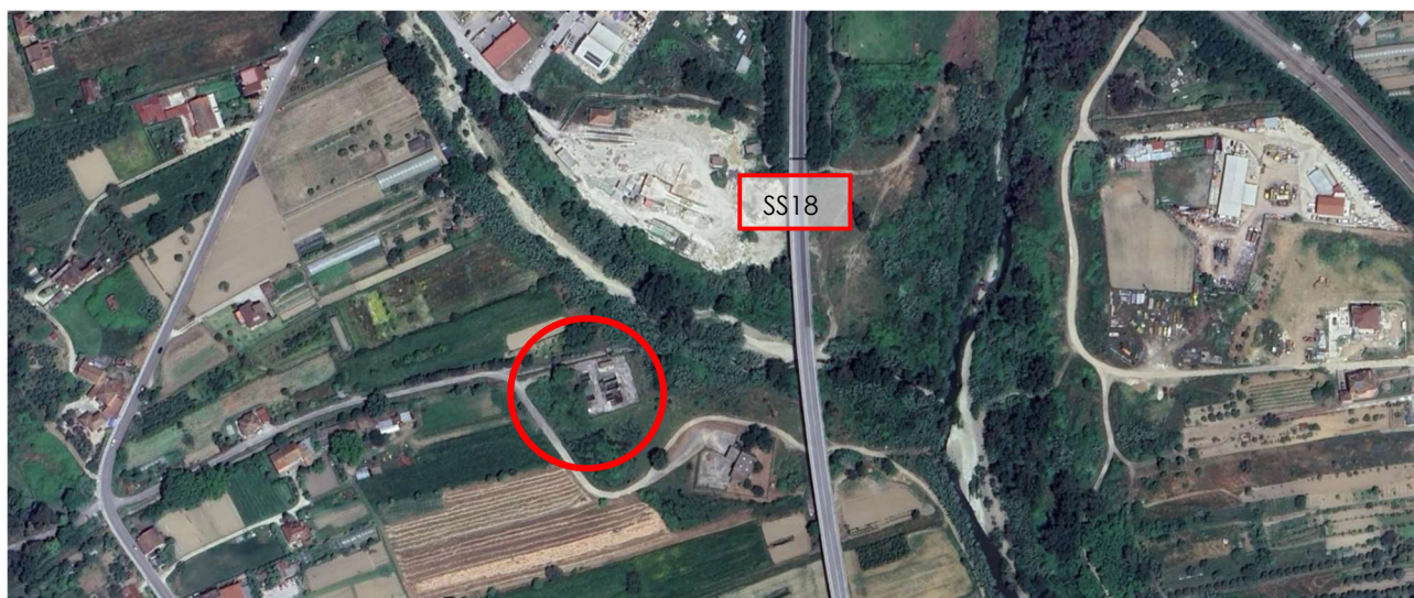
Figura 2: Inquadramento aerofotogrammetrico dell'area del futuro trattamento di essiccazione fanghi (in rosso) e della strada SS18
