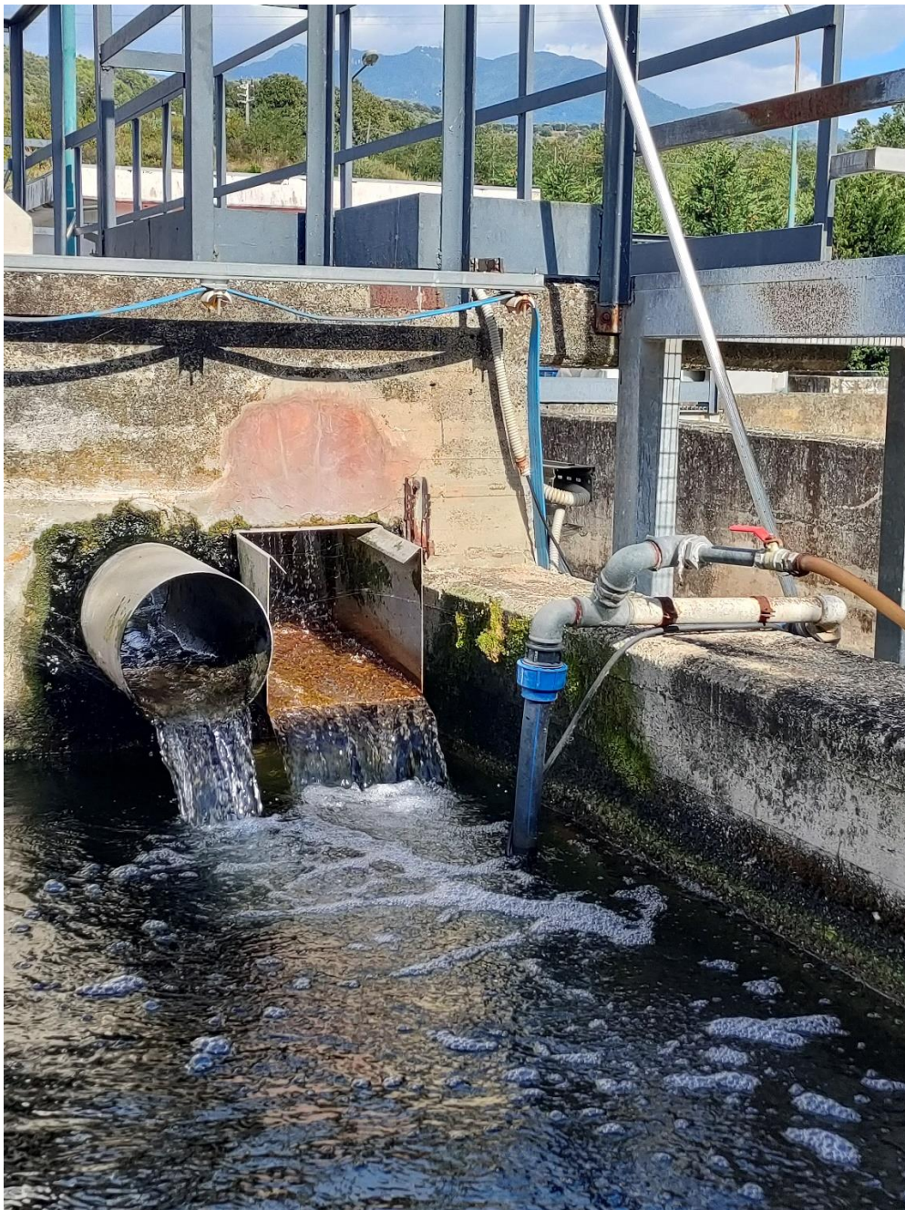
Figura 6: 5 – Prelievo acqua tecnica da disinfezione
