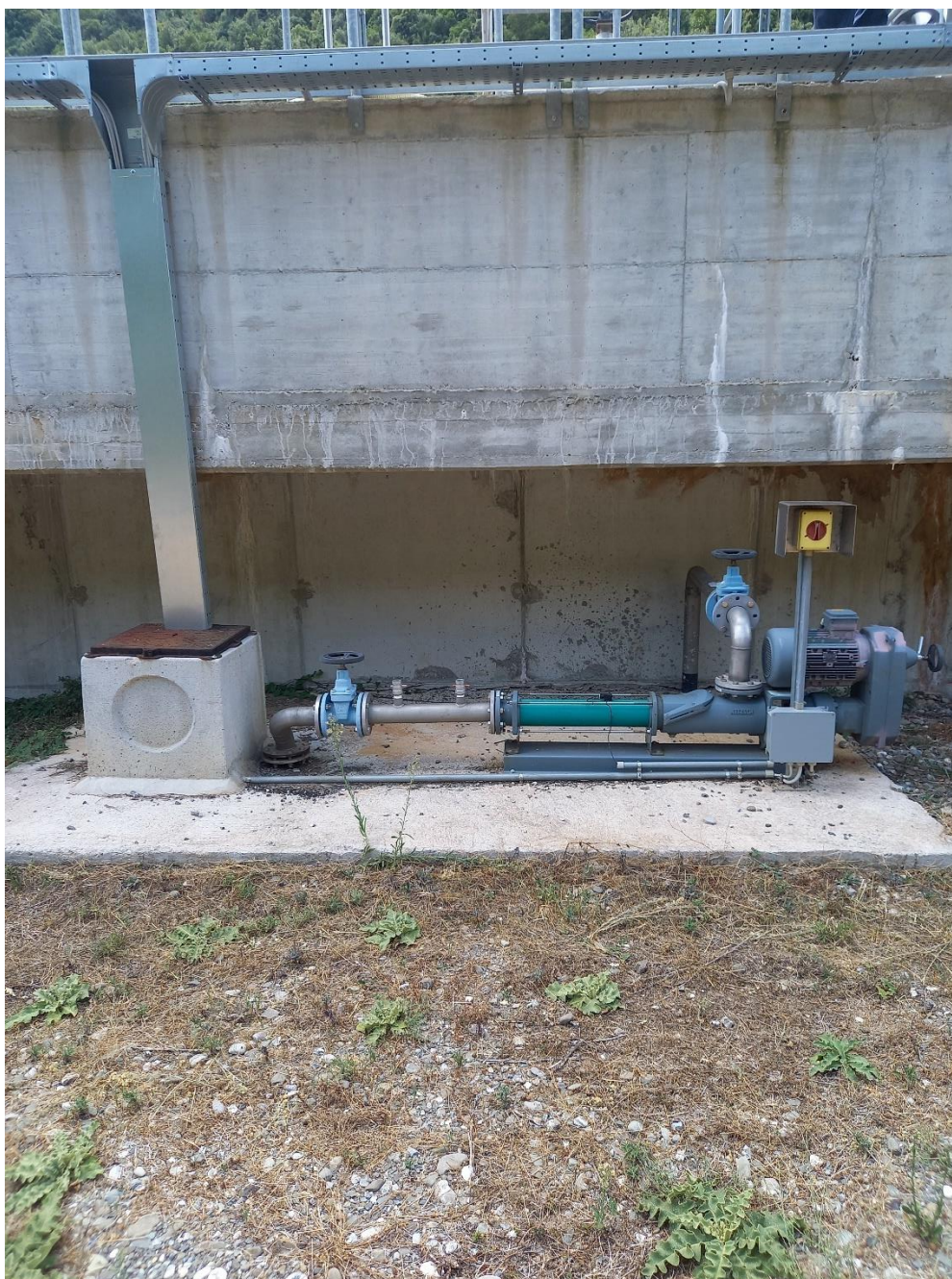
Figura 30: 3 – Pompa di alimentazione fanghi alla centrifuga
