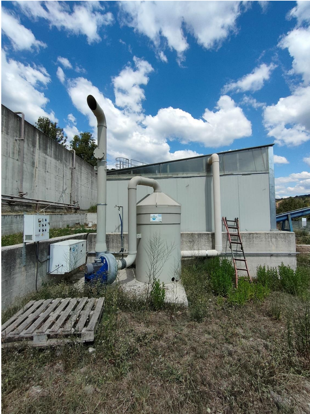
Figura 26: 8 – Scrubber locale disidratazione
