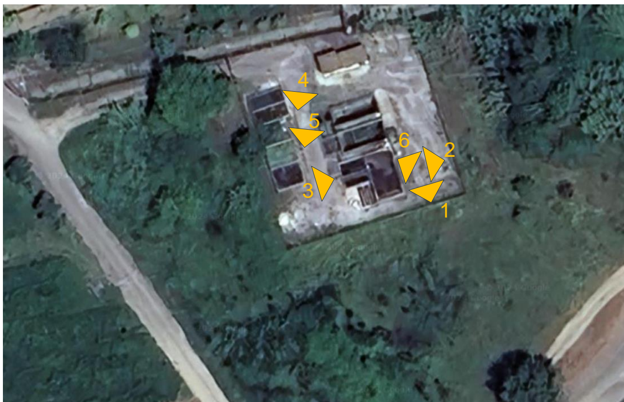
Figura 55: Ortofoto dell'area del futuro impianto di essiccamento di Omignano
