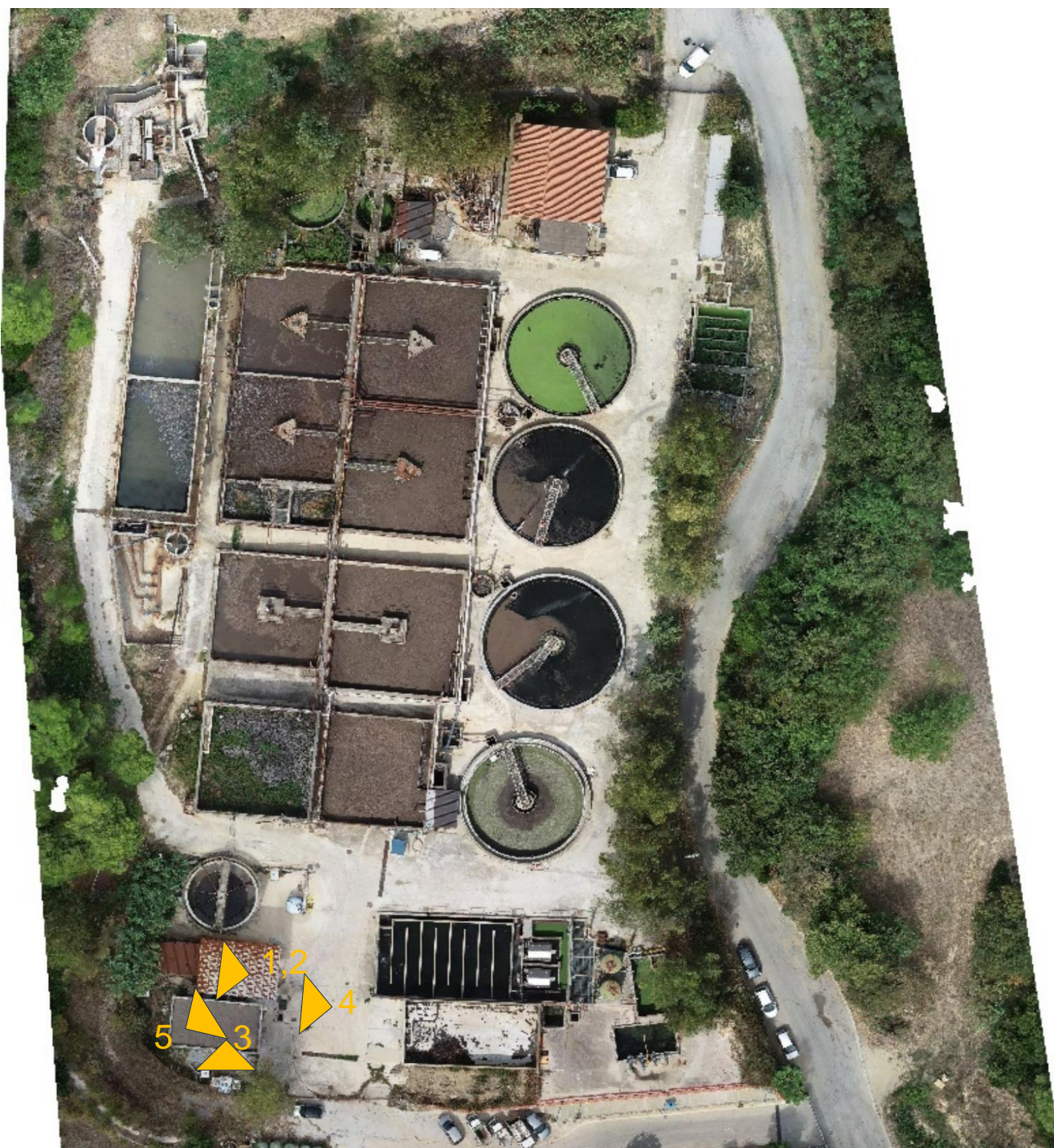
Figura 49: Ortofoto impianto di depurazione di Castellabate
