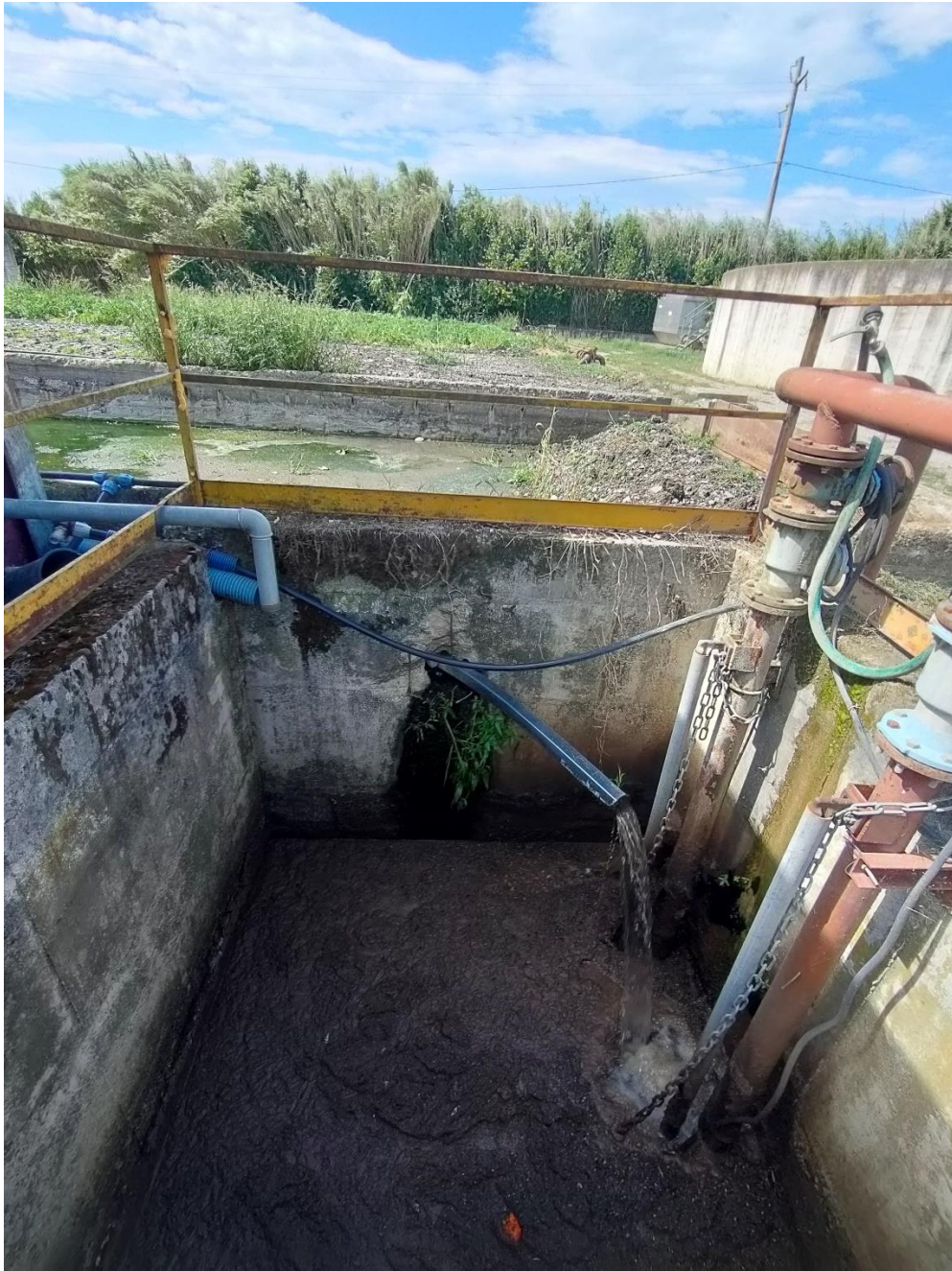
Figura 45: 4 – Pozzetto di accumulo e rilancio dreni
