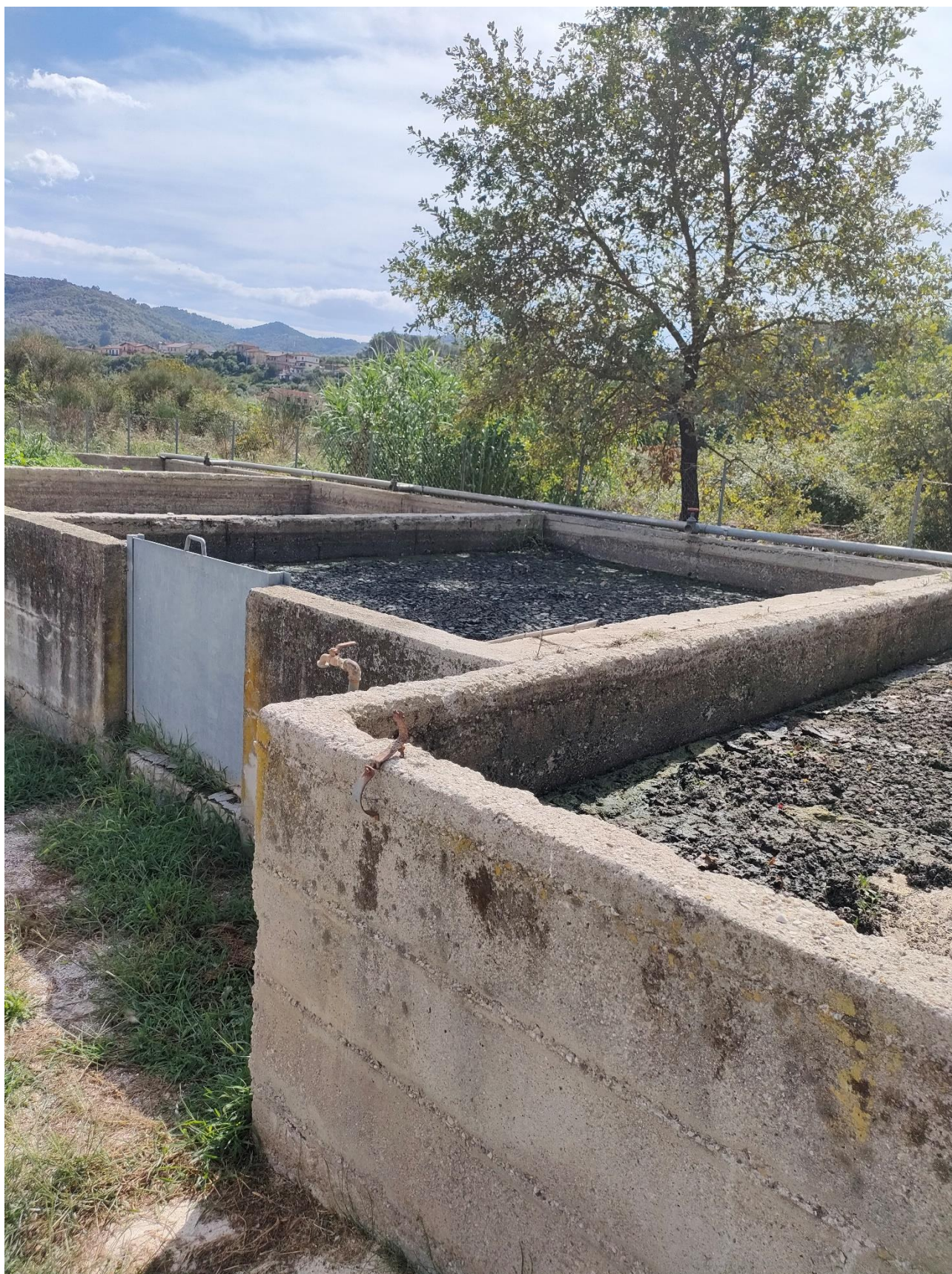
Figura 59: 4 – Letti di essiccamento del depuratore esistente e vista verso sud-ovest del sito del nuovo impianto
