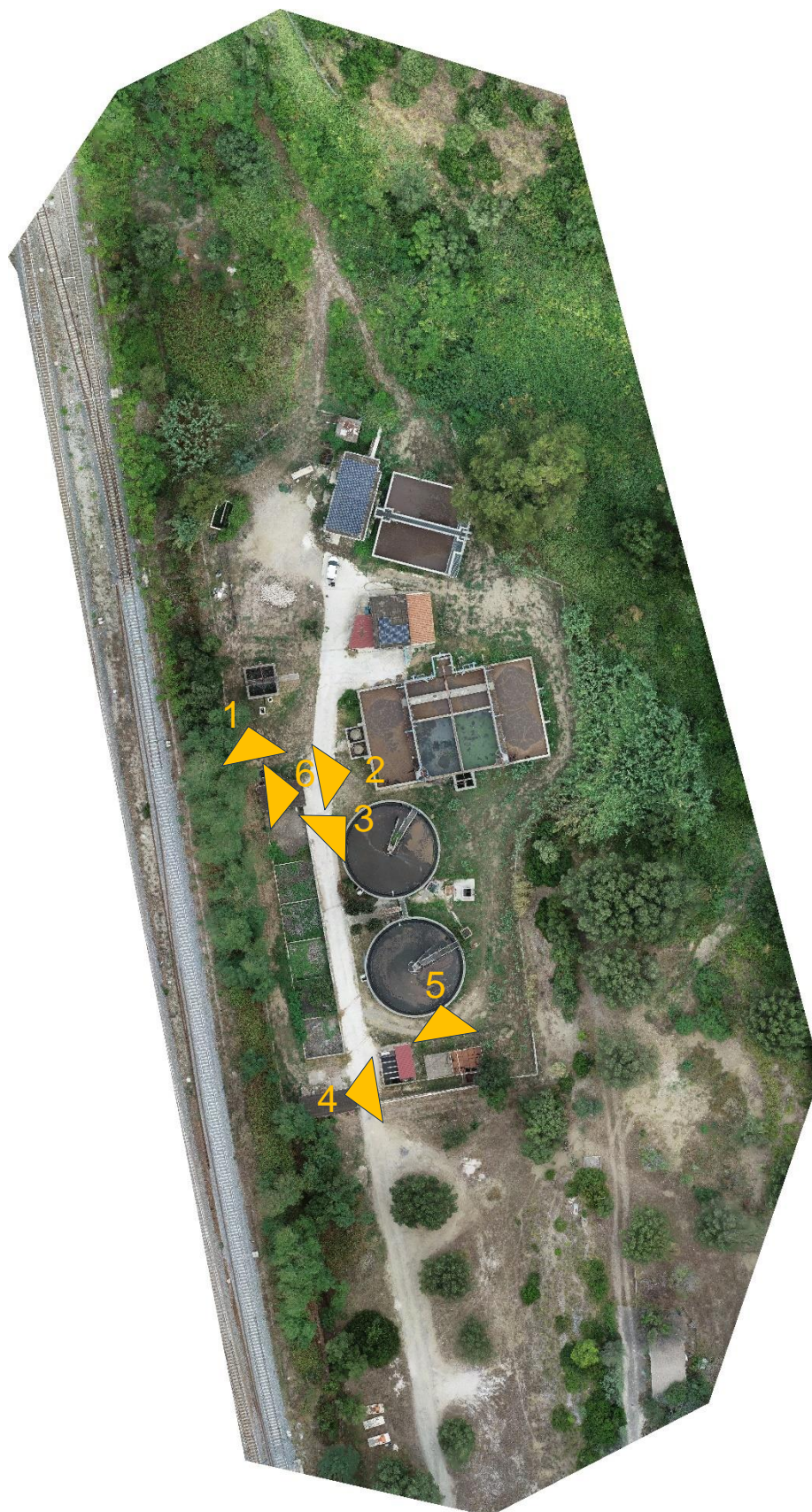
Figura 34: Ortofoto impianto di depurazione di Ascea Marina
