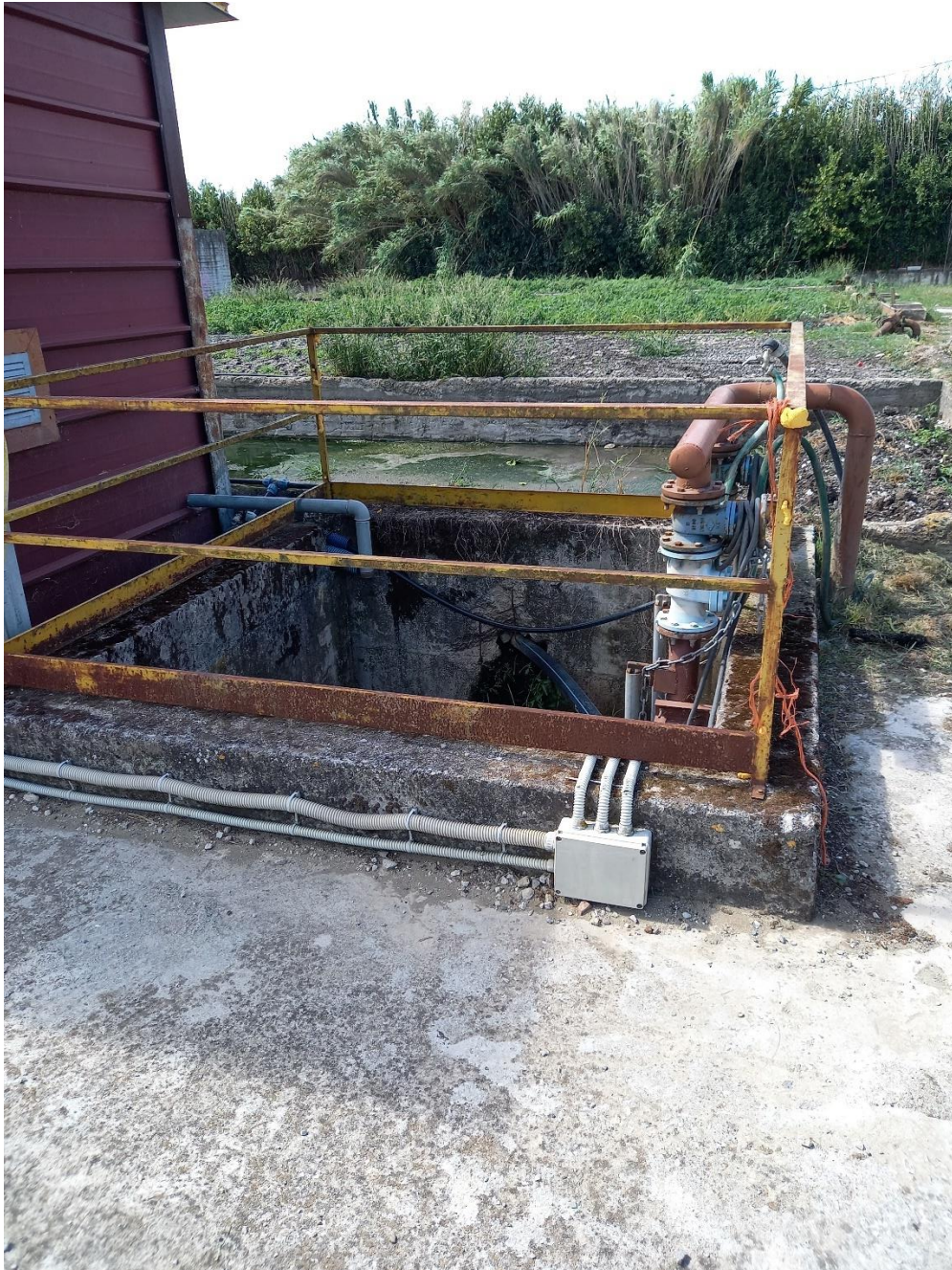
Figura 48: 7 - Pozzetto di accumulo e rilancio dreni
