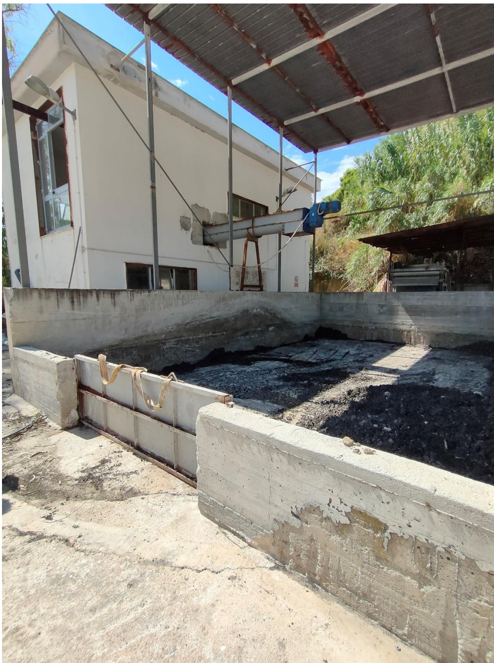
Figura 53: 4 – Letto essiccamento fanghi
