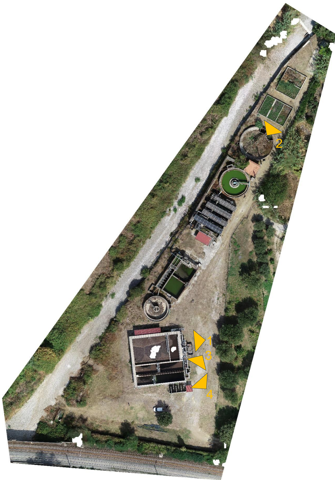
Figura 13: Ortofoto impianto di depurazione di Vibonati
