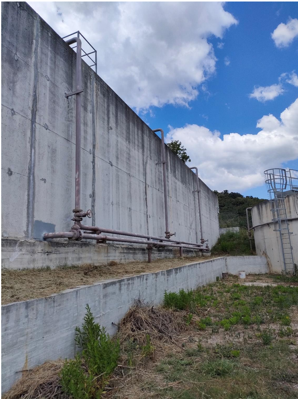
Figura 20: 2 – Comparto di digestione aerobica
