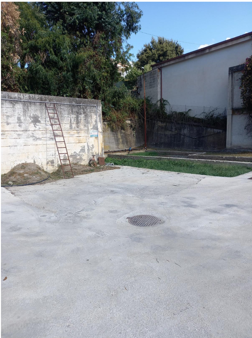
Figura 8: 1 – Ispessitore statico e letti di essiccamento
