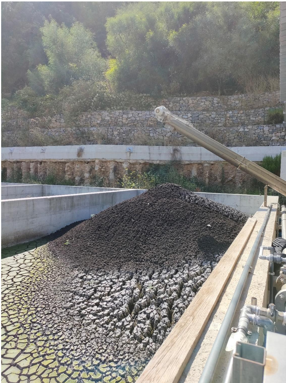
Figura 31: 4 – Letti di essiccamento fanghi
