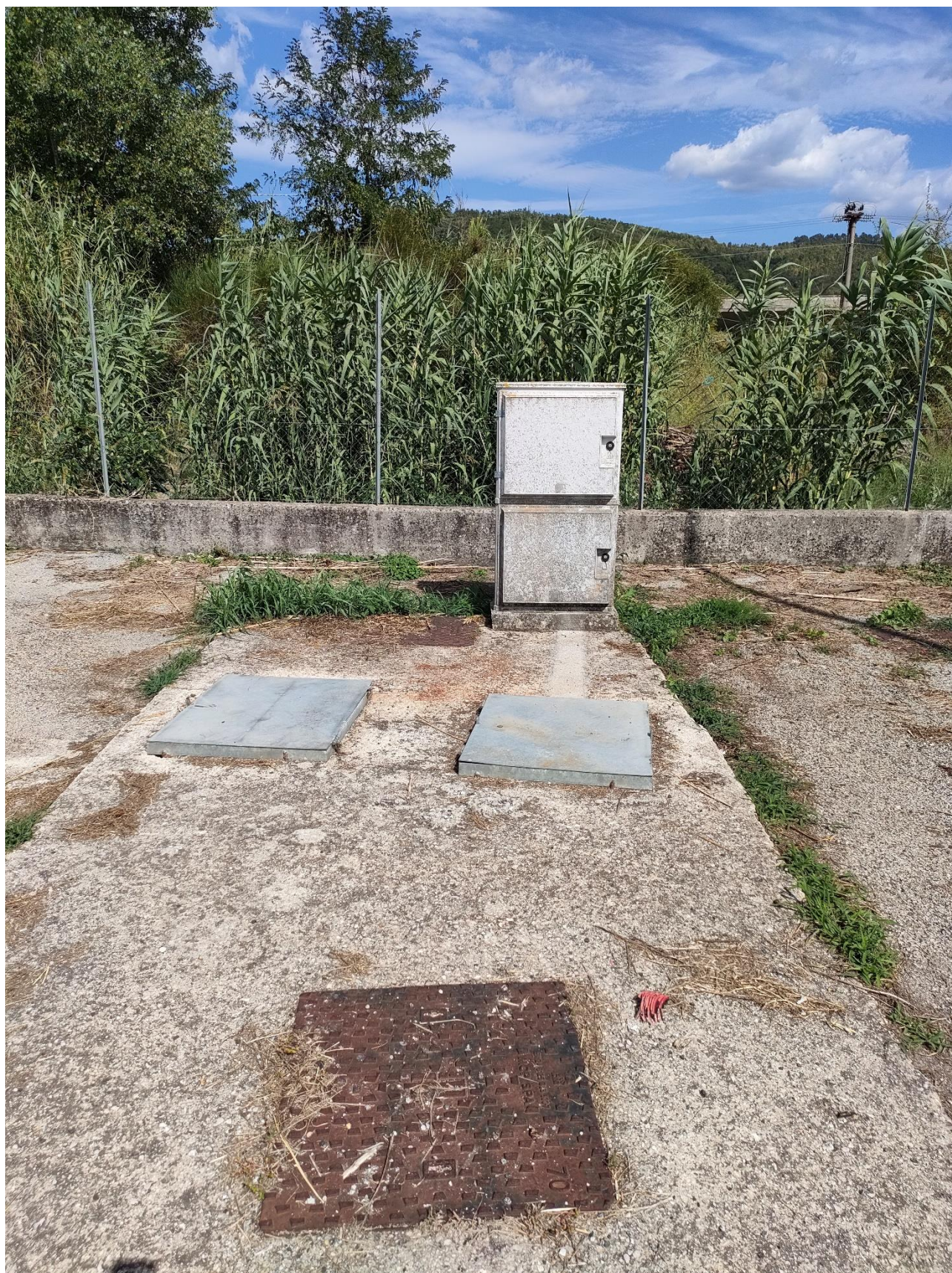
Figura 57: 2 - Vista verso est dal sito del depuratore esistente
