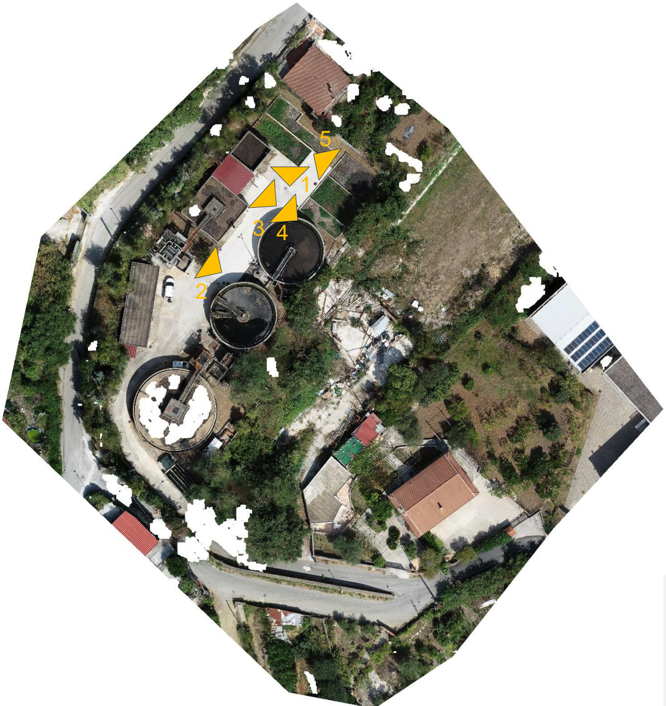
Figura 7: Ortofoto impianto di depurazione di Sapri
