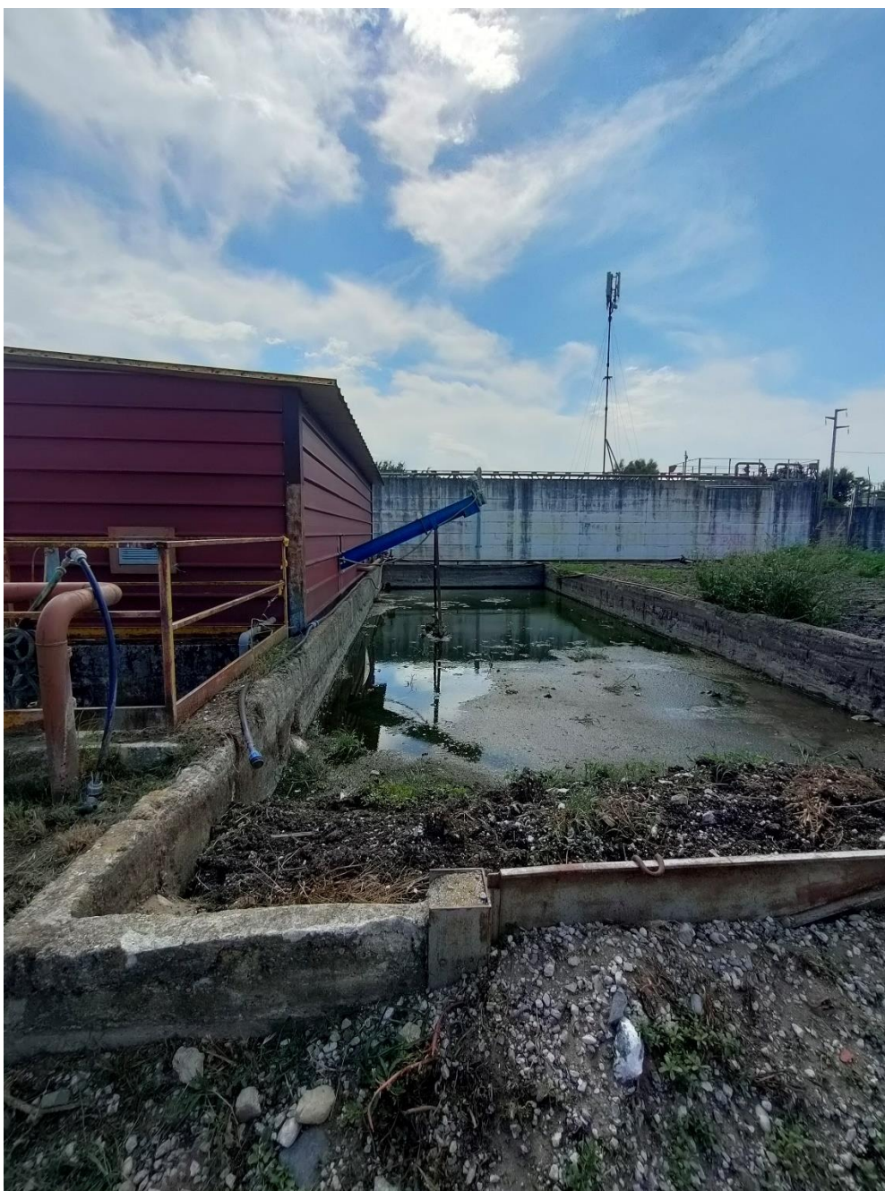
Figura 47: 6 – Letto di essiccamento da dismettere
