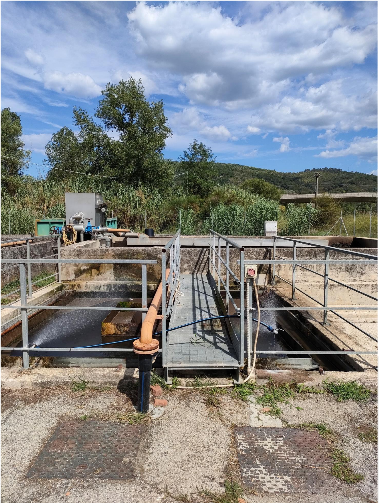
Figura 58: 3 – Vista verso est dal sito del depuratore esistente
