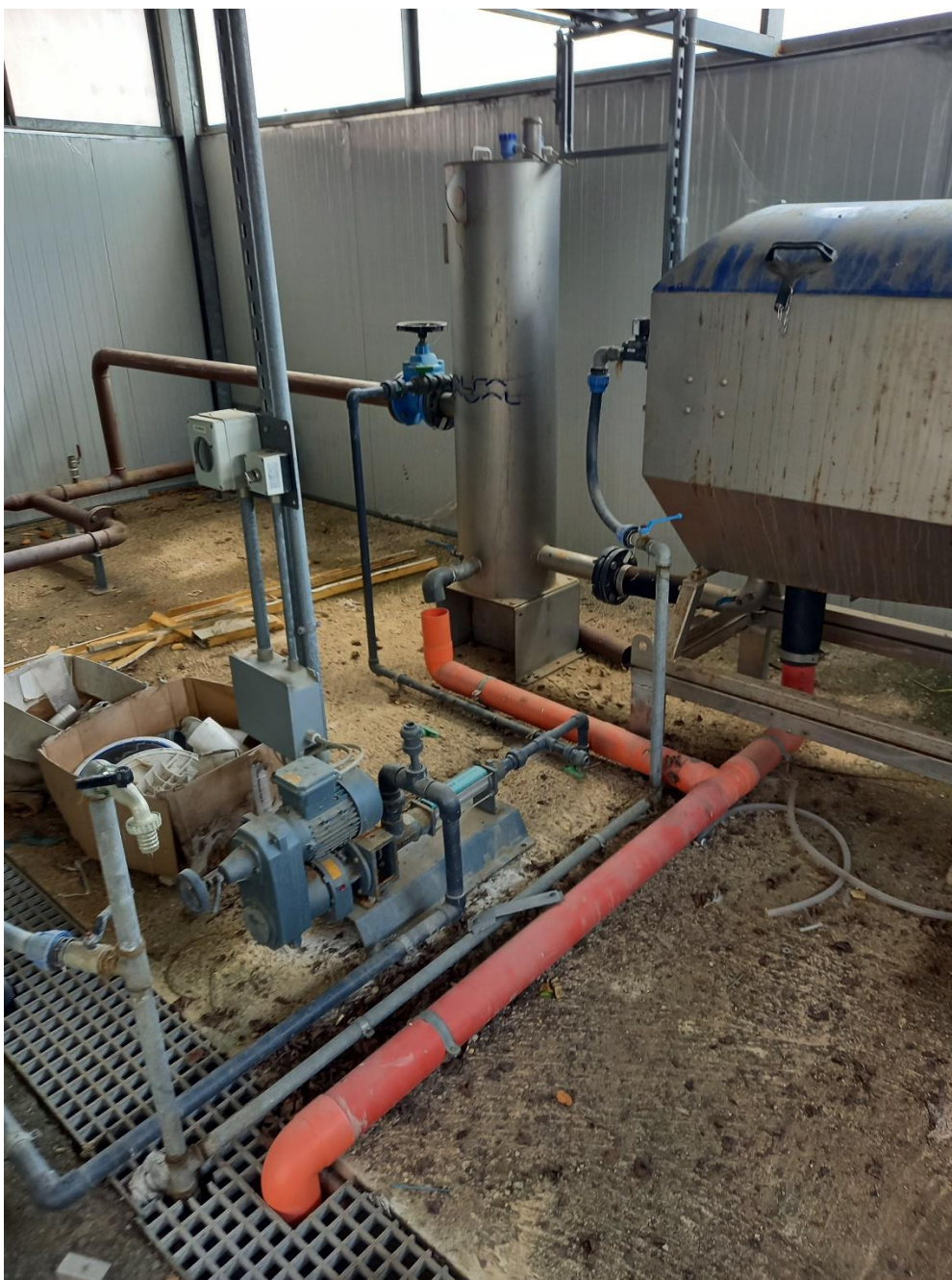
Figura 23: 5 – Locale disidratazione (non utilizzato)
