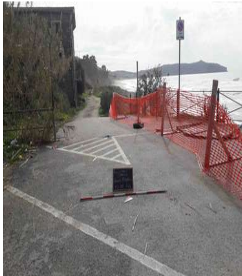
Tratto B1- verifica
