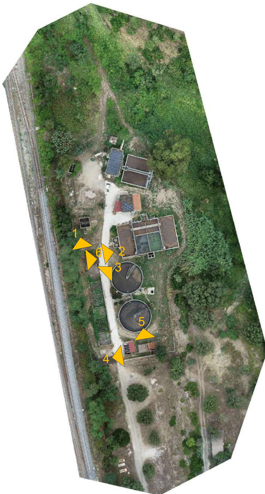
Figura 34: Ortofoto impianto di depurazione di Ascea Marina
