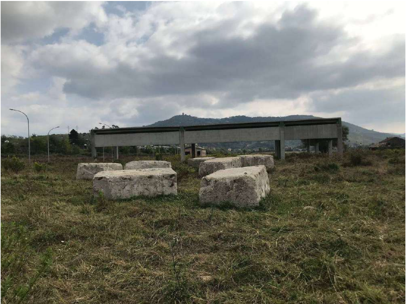
Figura 58: 3 -Area dell'impianto (vista da nord-ovest)
