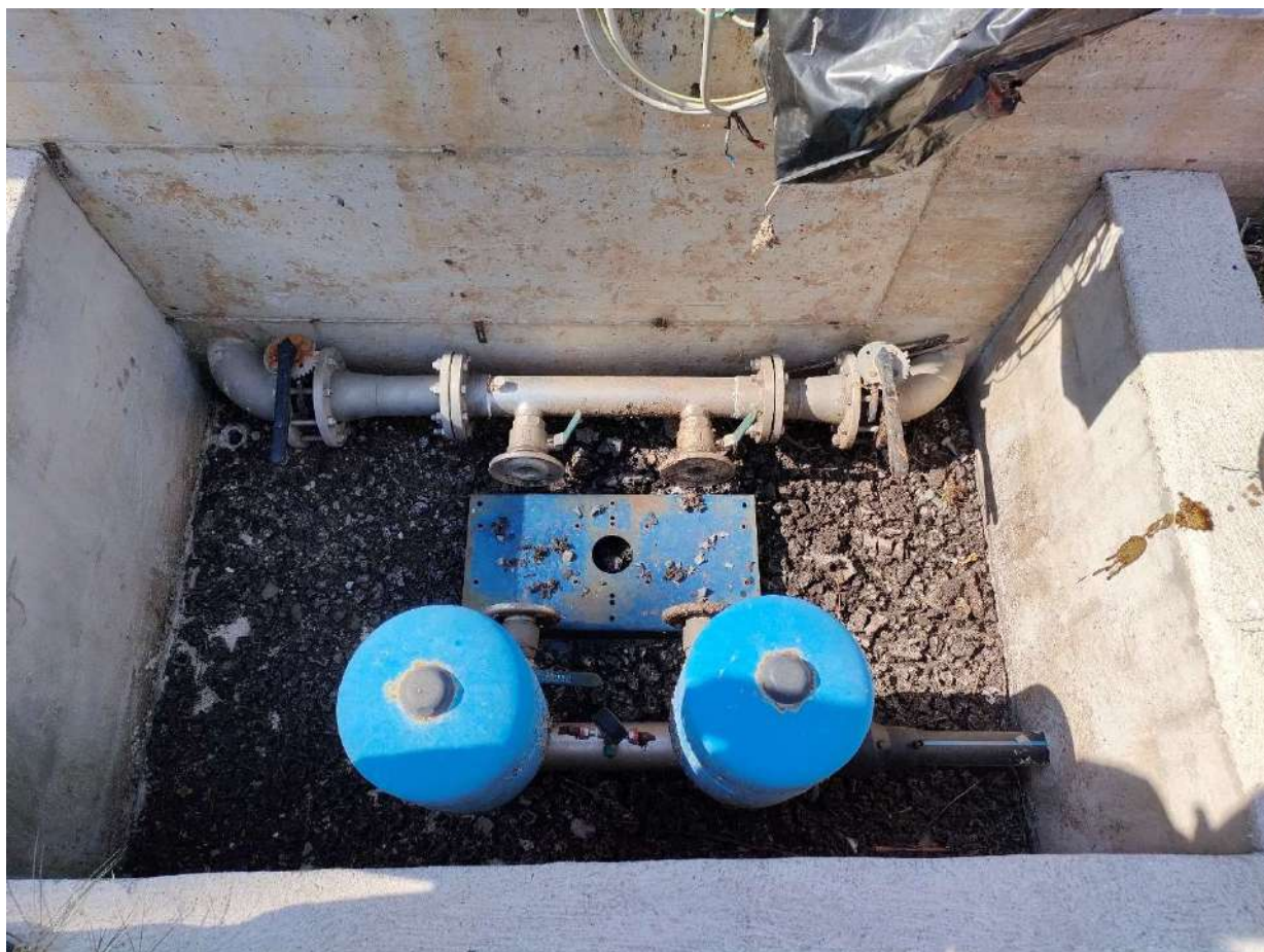
Figura 28: 1 – Predisposizione gruppo di pressurizzazione
