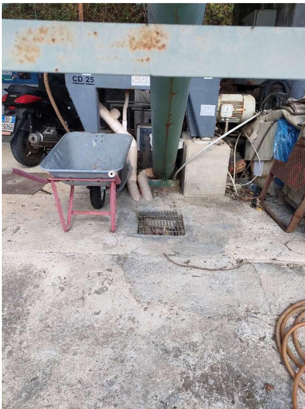
Figura 11: 4 – Pozzetto dreni platea disidratazione
