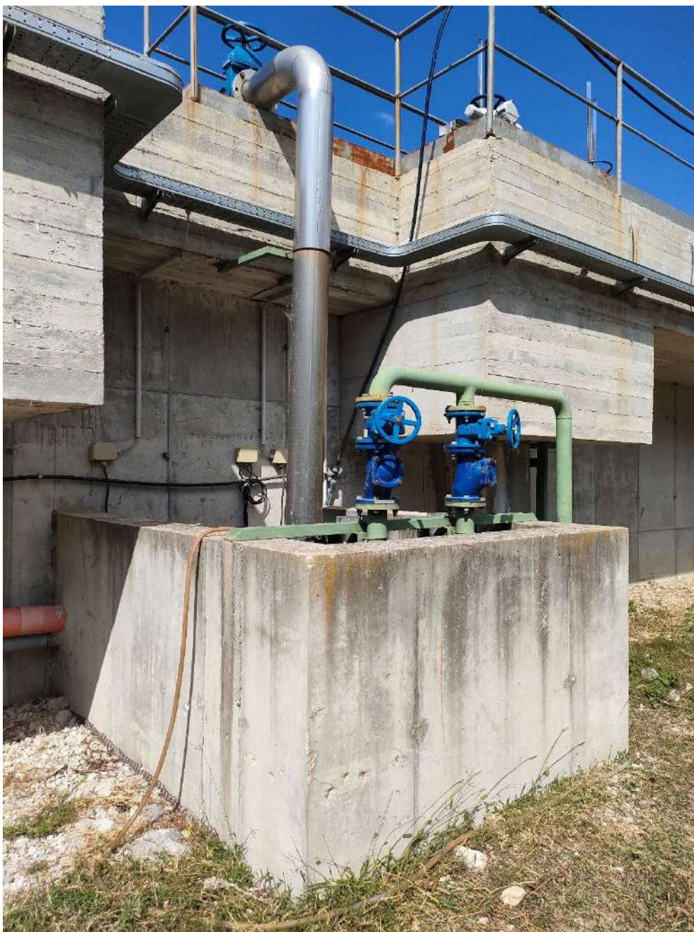
Figura 17: 4 – Pozzetto fanghi di supero
