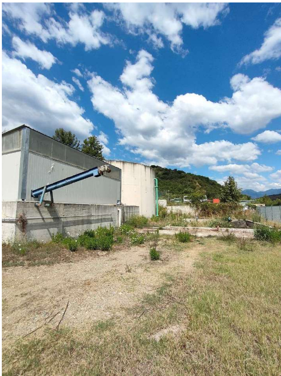
Figura 19: 1 – Coclea fanghi disidratati e letti di essiccamento
