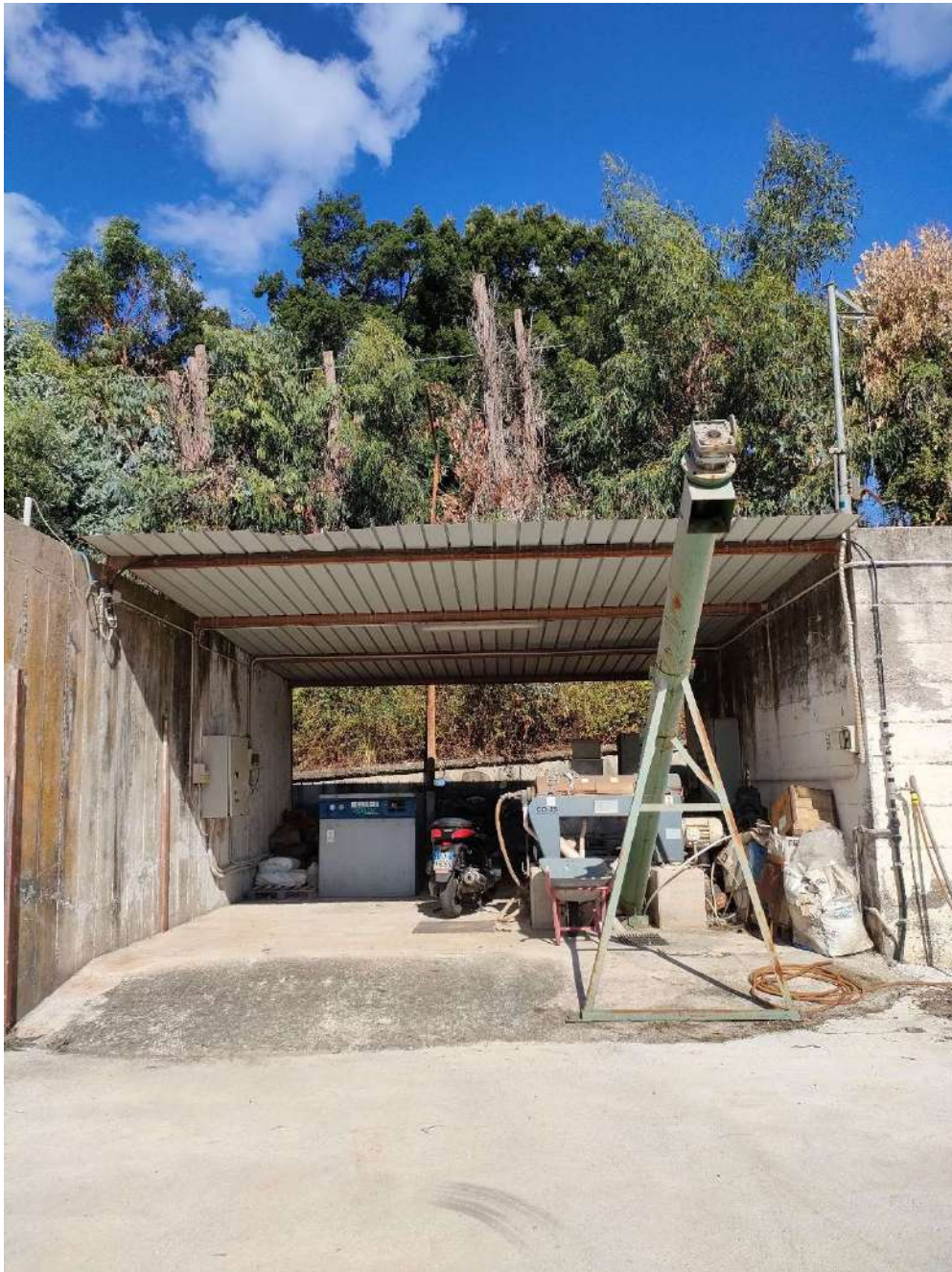
Figura 10: 3 – Tettoia disidratazione fanghi
