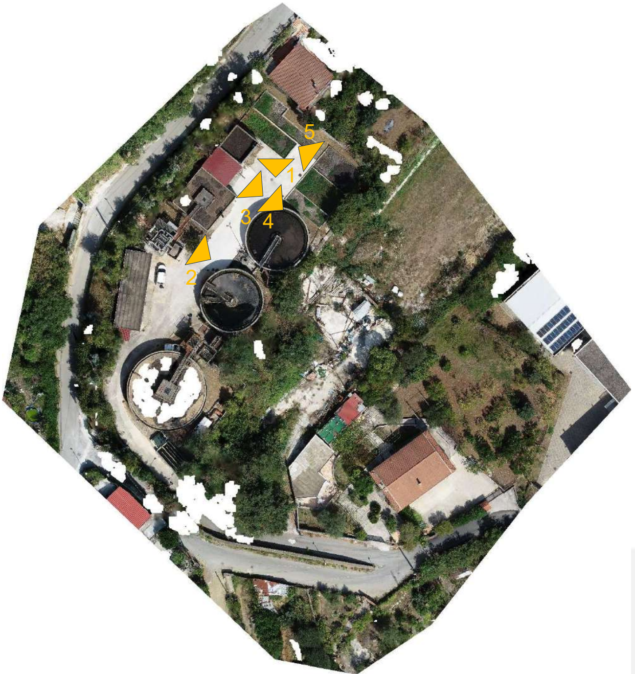
Figura 7: Ortofoto impianto di depurazione di Sapri
