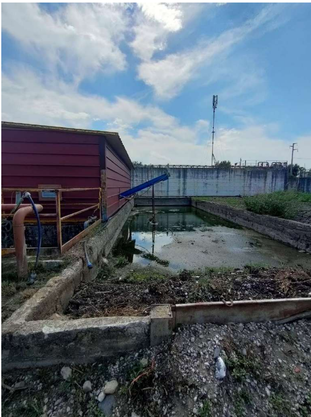
Figura 47: 6 – Letto di essiccamento da dismettere
