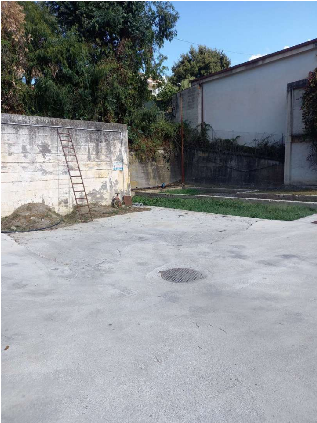
Figura 8: 1 – Ispessitore statico e letti di essiccamento
