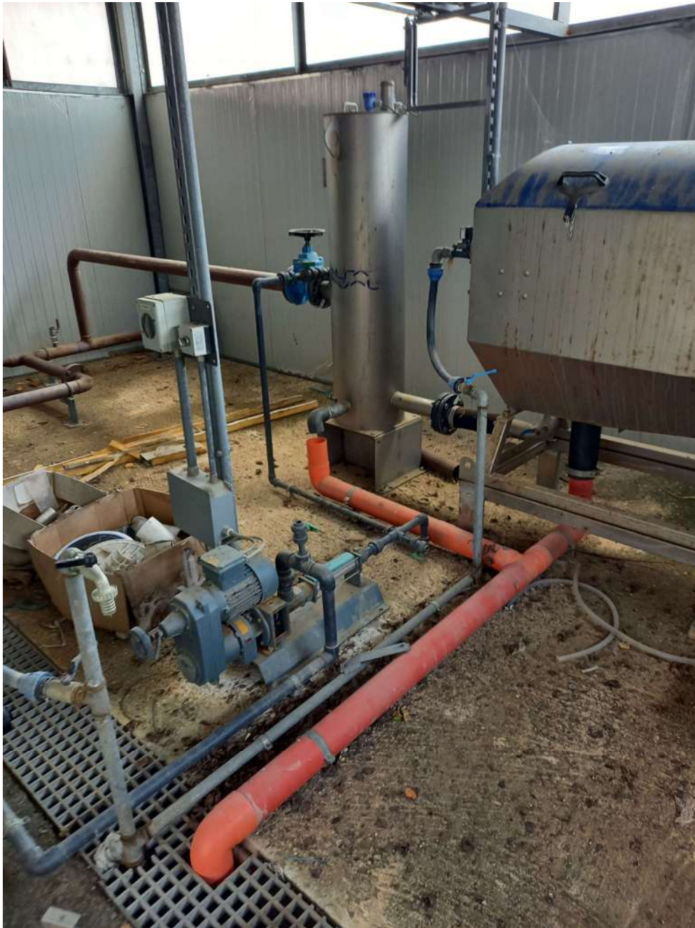
Figura 23: 5 – Locale disidratazione (non utilizzato)
