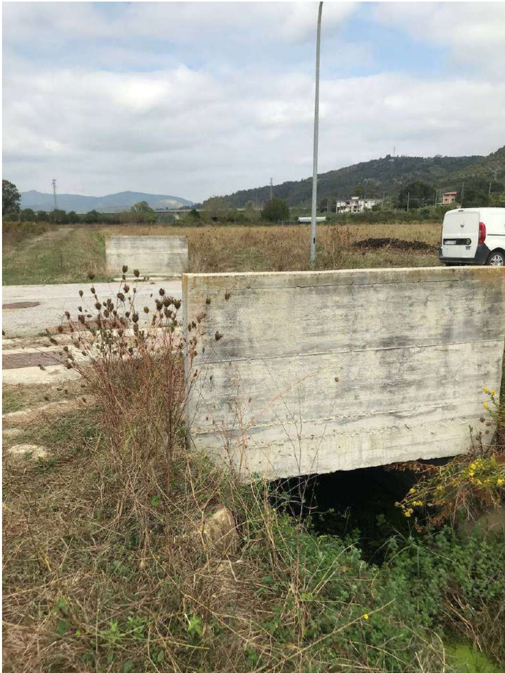
Figura 61: 6 – Attraversamento del canale
