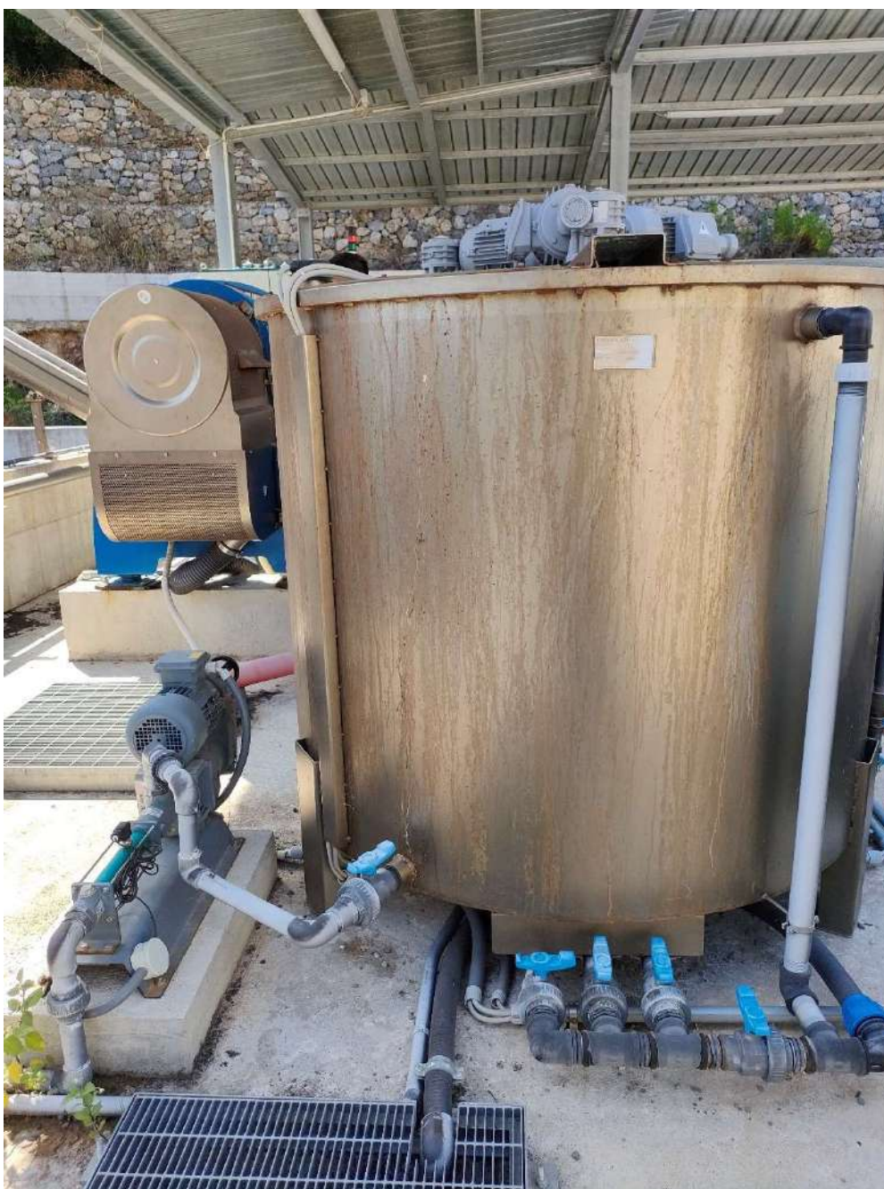
Figura 32: 5 – Polipreparatore automatico
