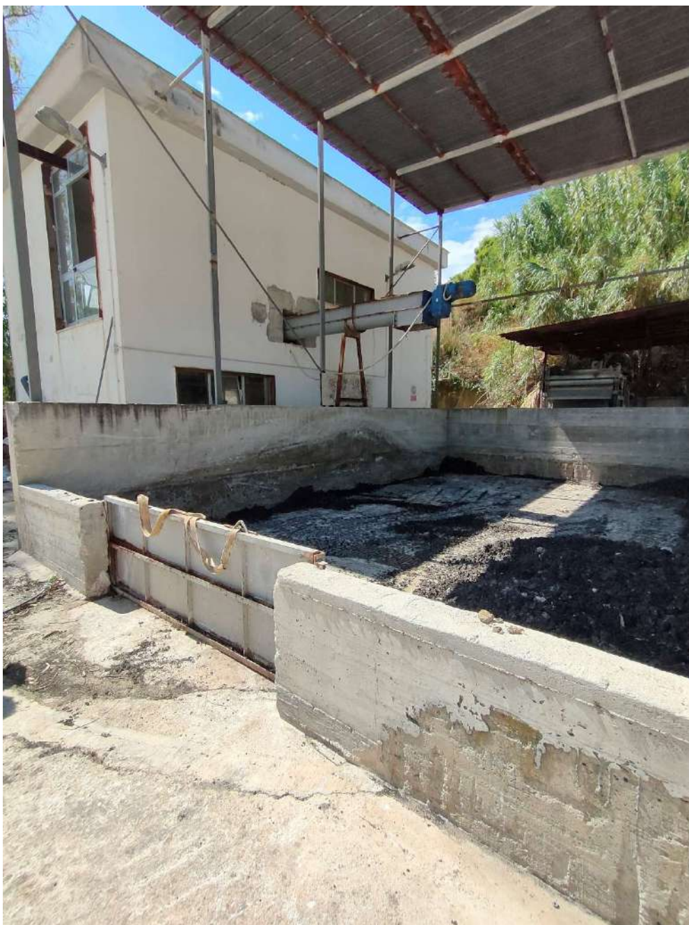
Figura 53: 4 – Letto essiccamento fanghi
