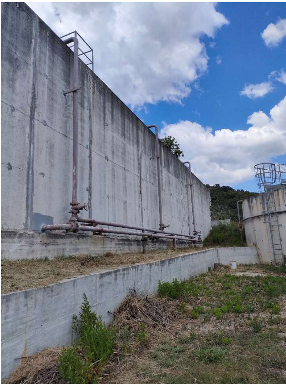
Figura 20: 2 – Comparto di digestione aerobica
