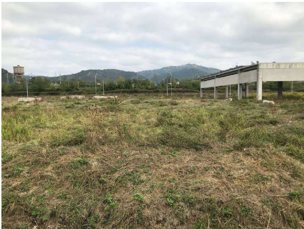
Figura 60: 5 - Area dell'impianto (vista da sud-ovest)
