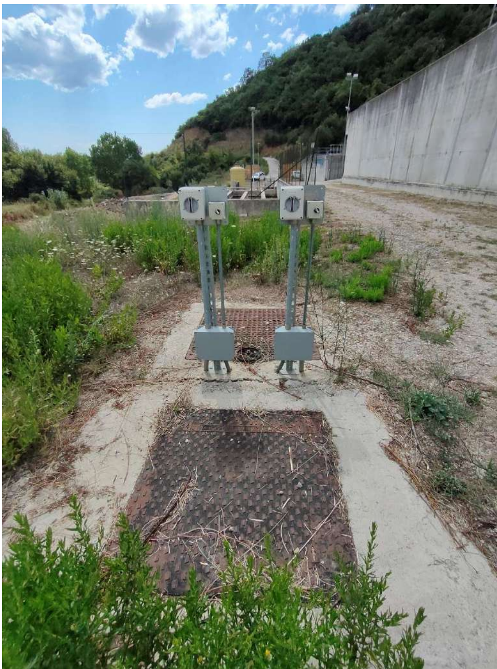
Figura 25: 7 – Pozzetto raccolta e sollevamento dreni
