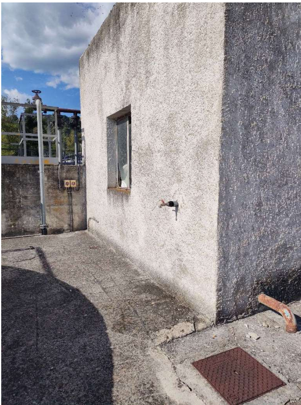
Figura 4: 3 – Locale disidratazione dismesso, acqua potabile e mandata ispessitore esistente
