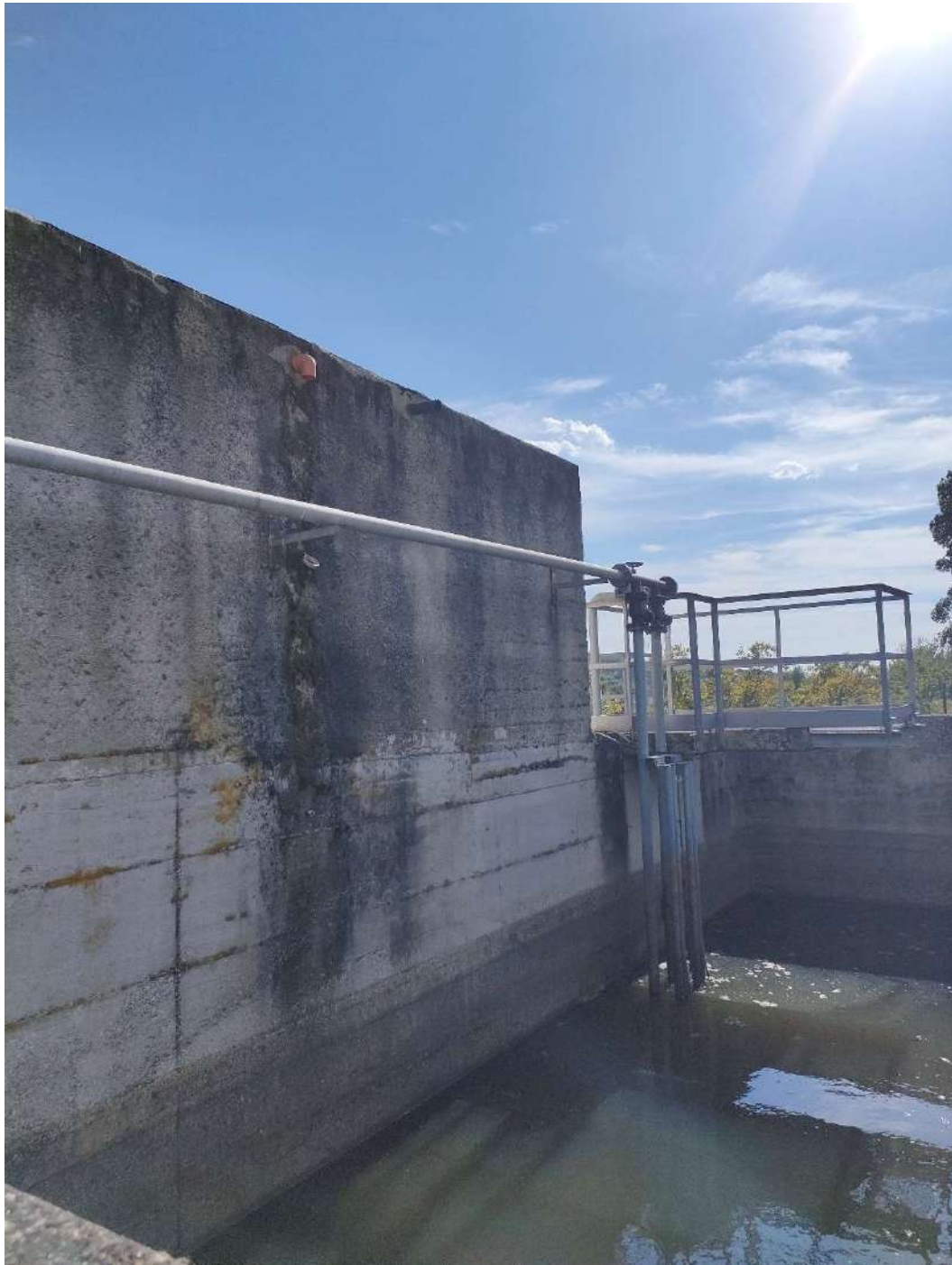
Figura 2: 1 – Sollevamento digestione aerobica
