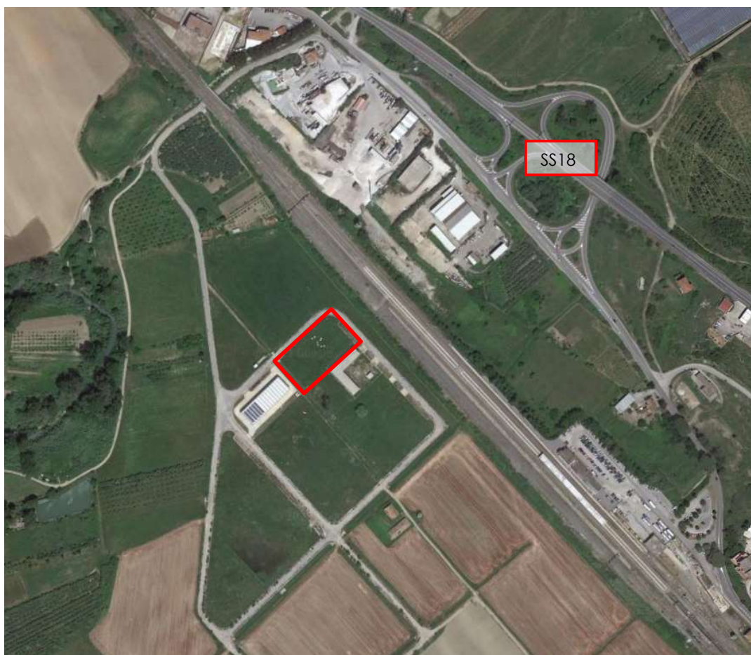
Figura 4: Inquadramento aerofotogrammetrico dell'area del futuro trattamento di essiccazione fanghi (in rosso) e della strada SS18
