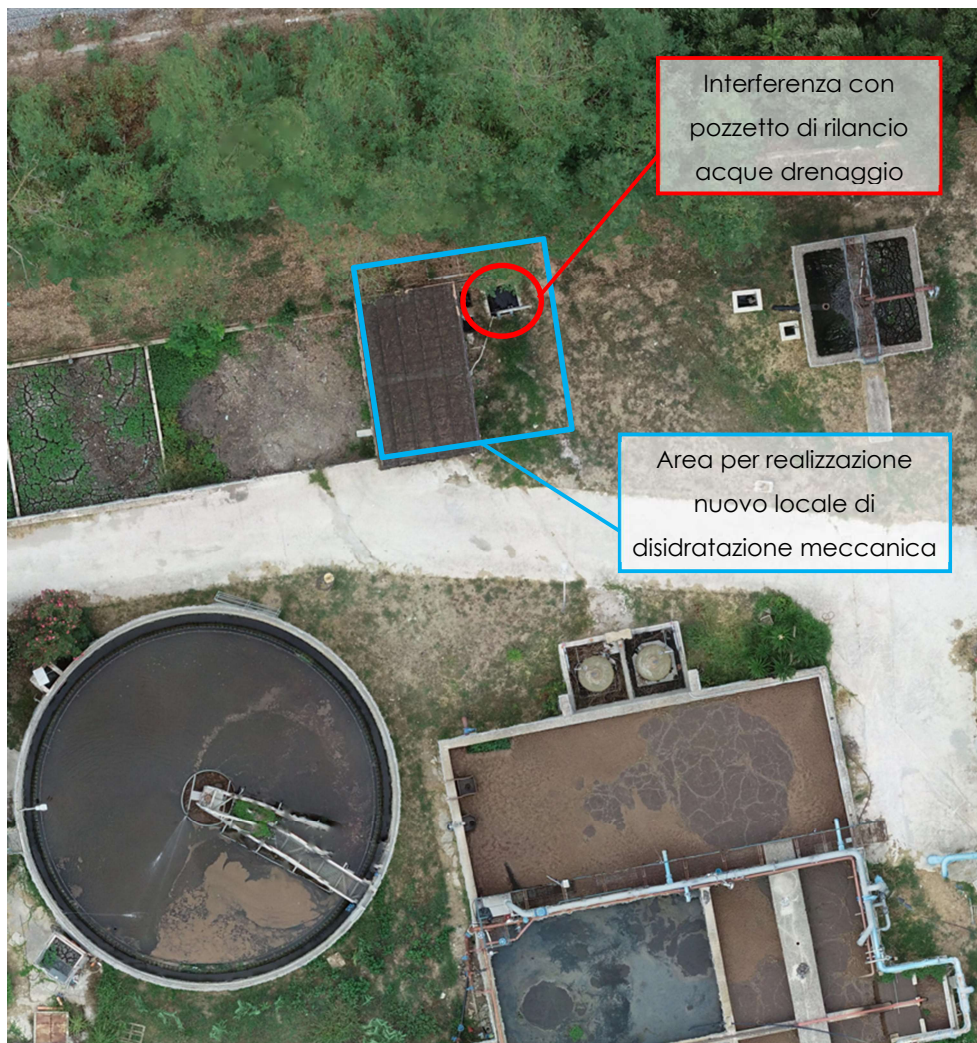
Figura 6: Individuazione su ortofoto dell'interferenza superficiale nell'impianto di Ascea
