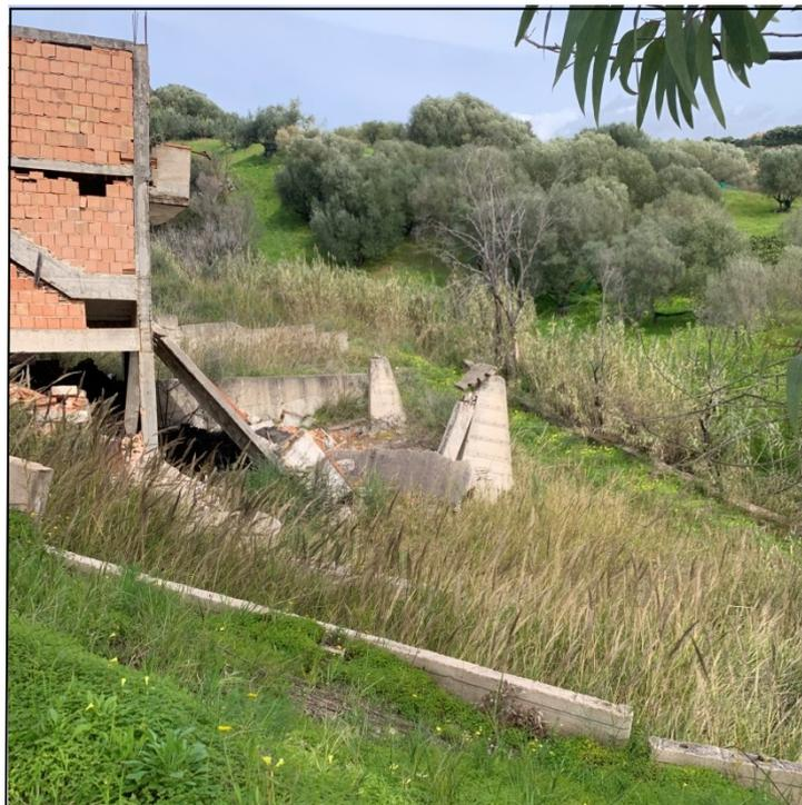
Il progetto, nel tratto alto della rete fognaria lungo Via di Piano del Pero, prevede l'alloggiamento della condotta lungo una pista in terra che si sviluppa su un crinale de posizionale. La condotta fognaria sarà ubicata a monte della stradina in deformazione.
