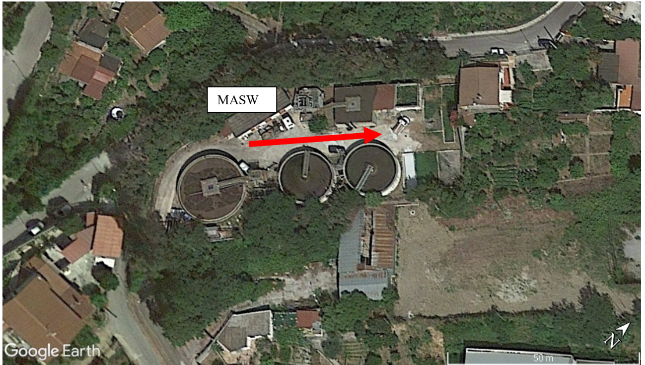
Figura 2 - Ubicazione dello stendimento messo in opera su foto aerea.
