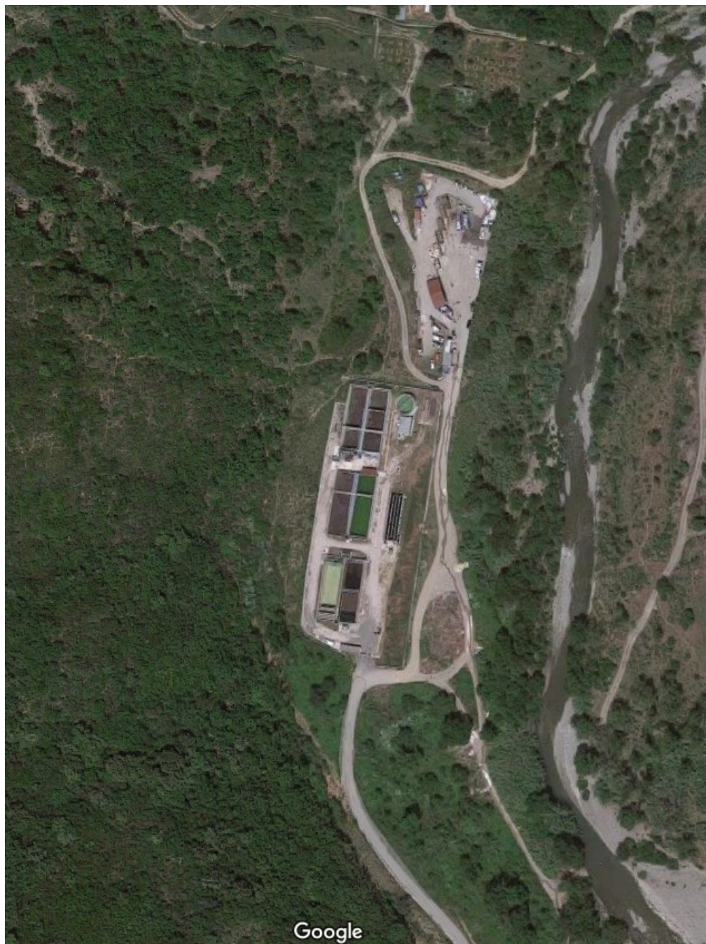
Figura 5: Dettaglio dell'impianto di Centola Portigliola.
