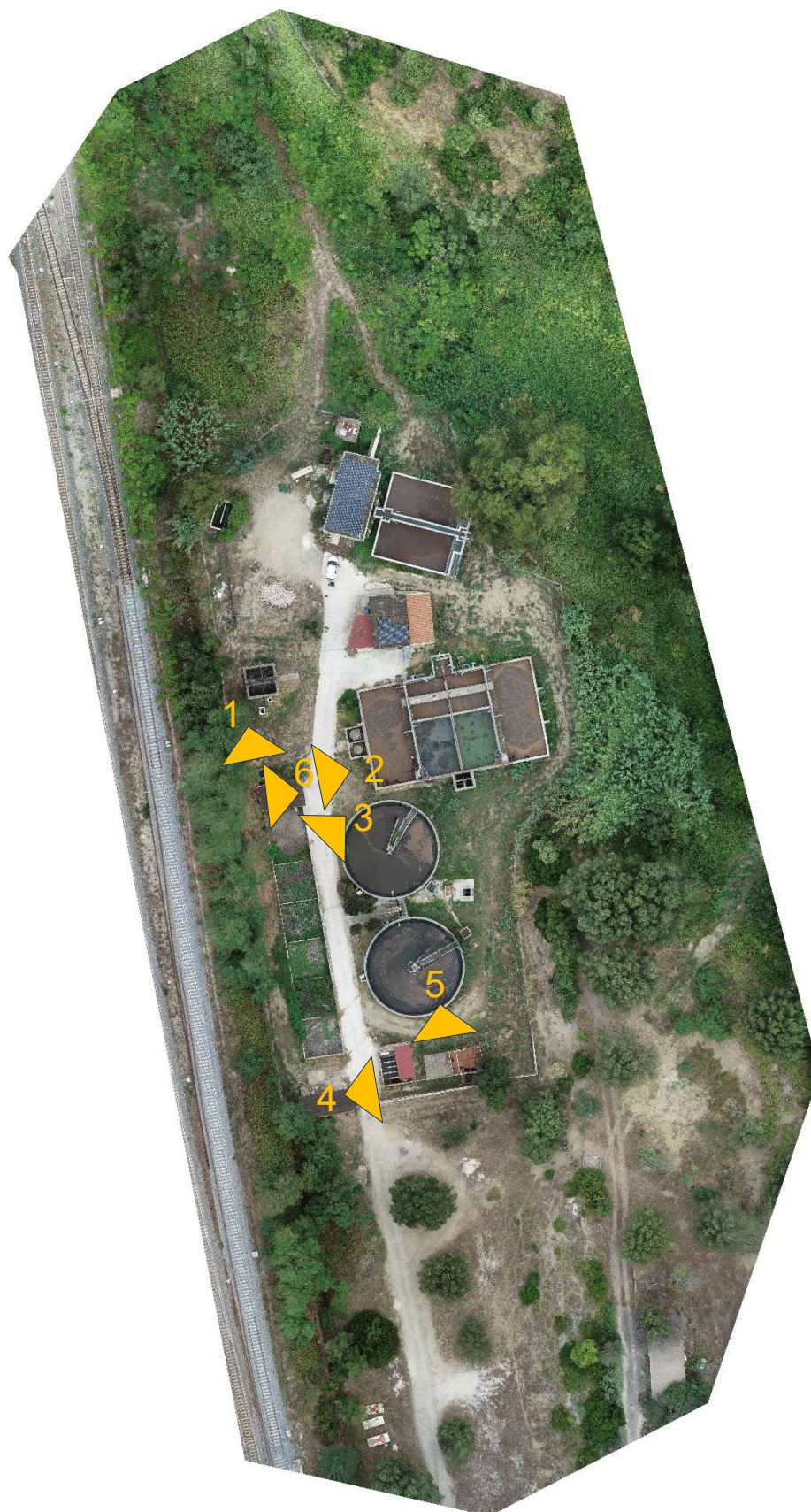
Figura 34: Ortofoto impianto di depurazione di Ascea Marina
