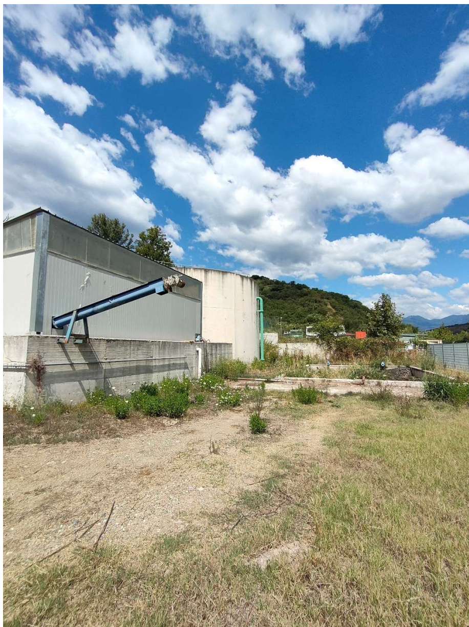
Figura 19: 1 – Coclea fanghi disidratati e letti di essiccamento
