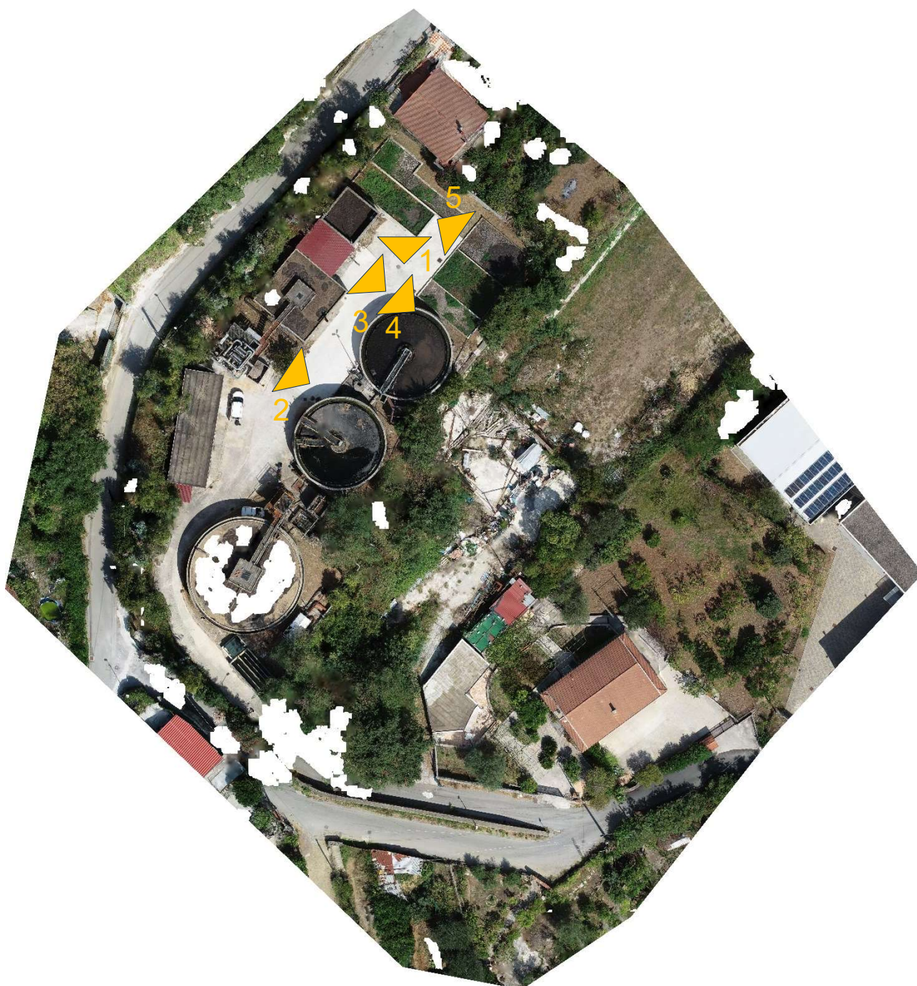
Figura 7: Ortofoto impianto di depurazione di Sapri
