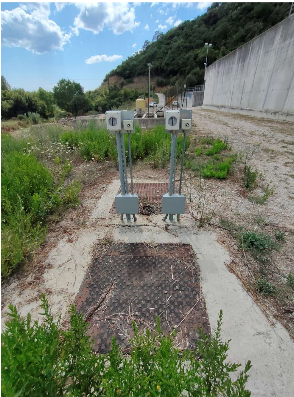
Figura 25: 7 – Pozzetto raccolta e sollevamento dreni
