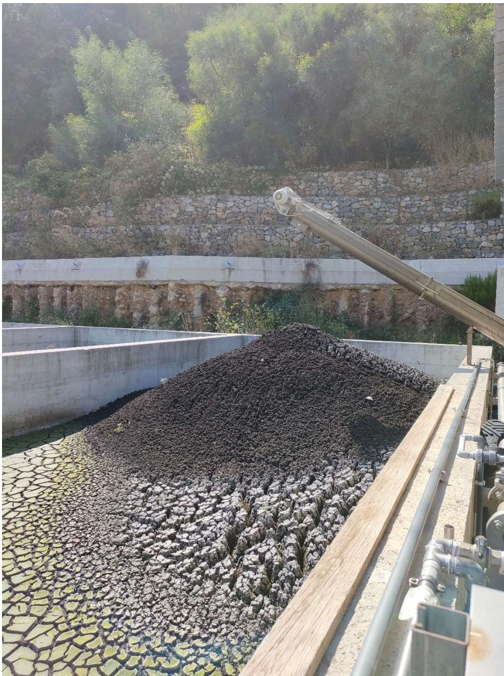
Figura 31: 4 – Letti di essiccamento fanghi
