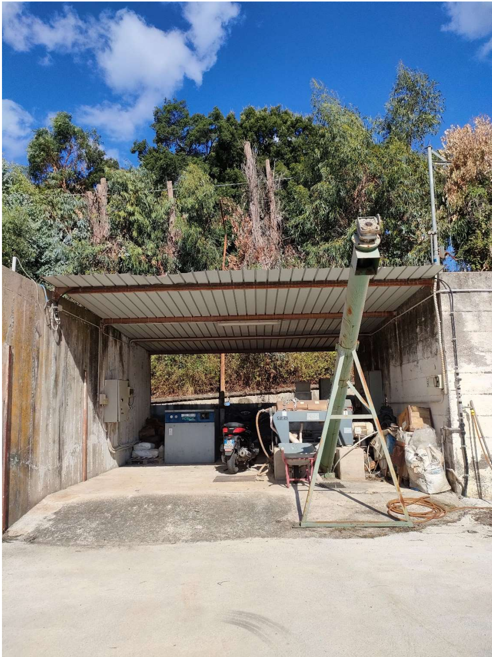
Figura 10: 3 – Tettoia disidratazione fanghi
