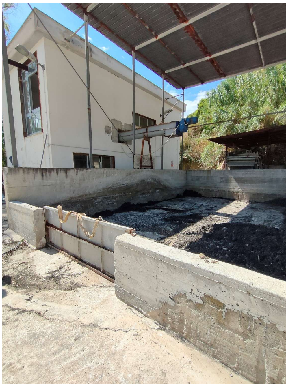
Figura 53: 4 – Letto essiccamento fanghi
