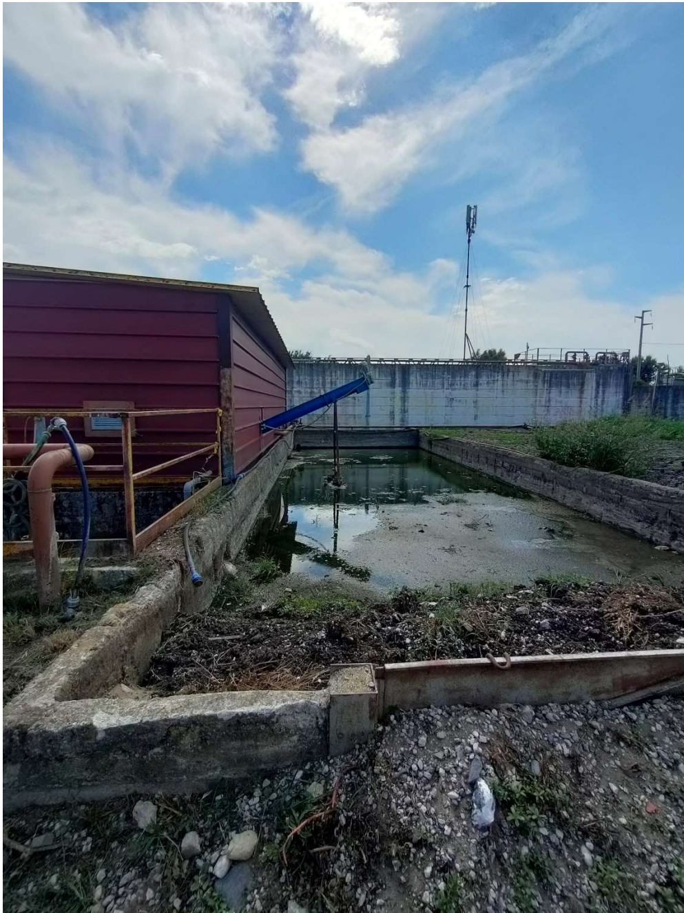
Figura 47: 6 – Letto di essiccamento da dismettere
