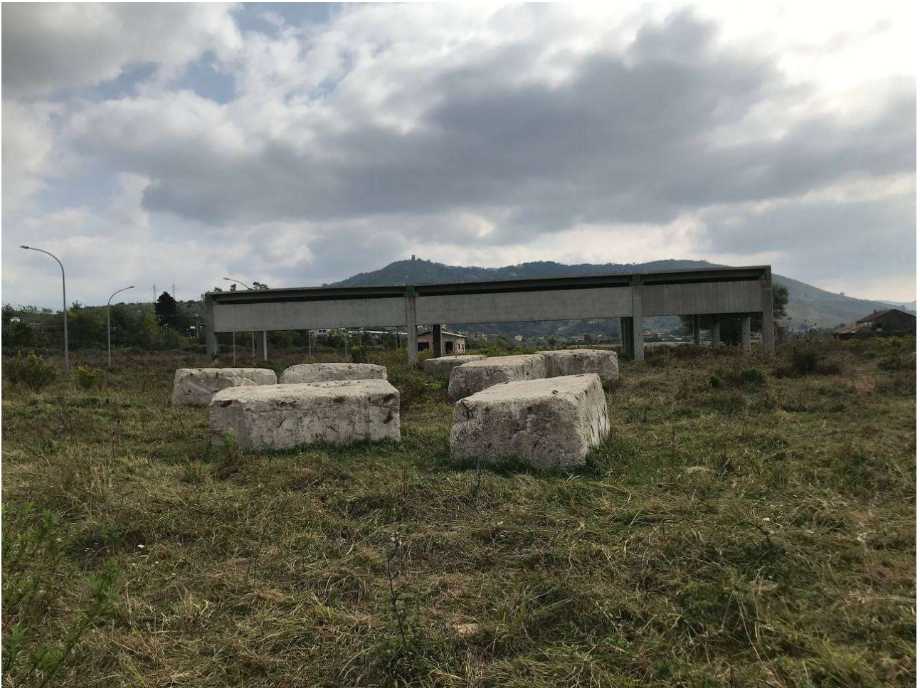
Figura 58: 3 -Area dell'impianto (vista da nord-ovest)
