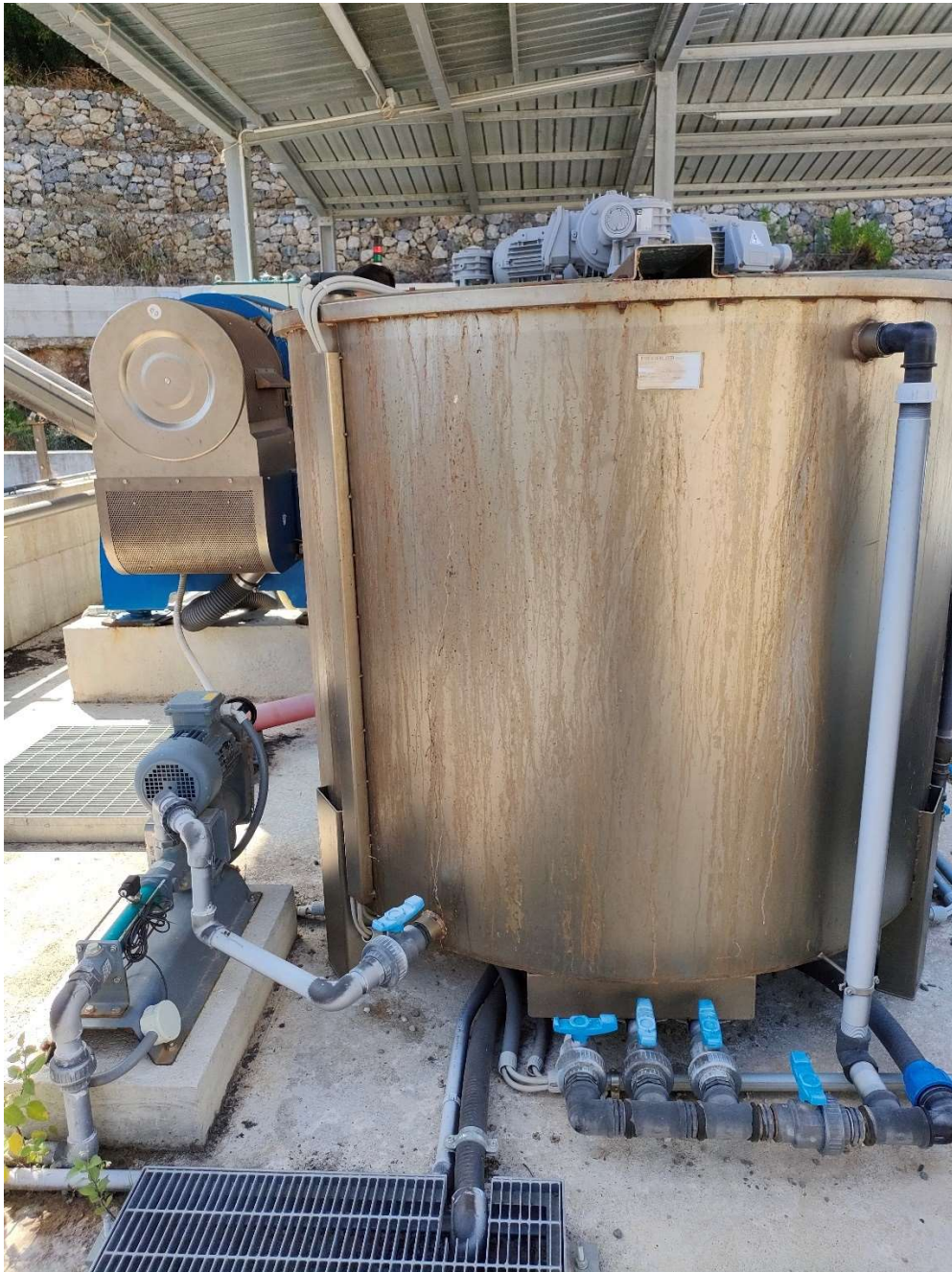
Figura 32: 5 – Polipreparatore automatico
