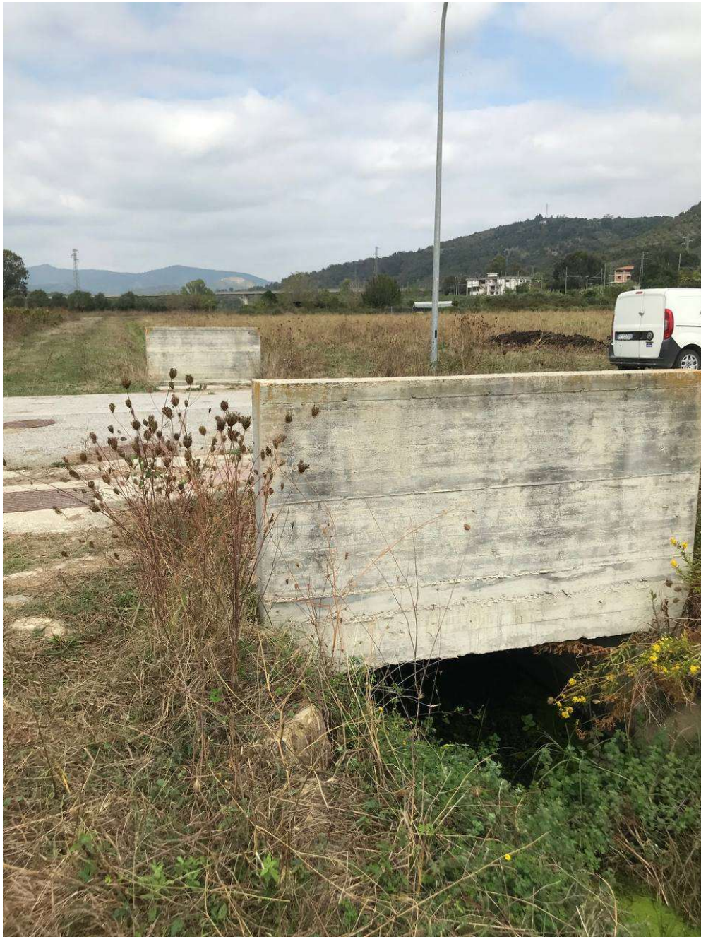
Figura 61: 6 – Attraversamento del canale
