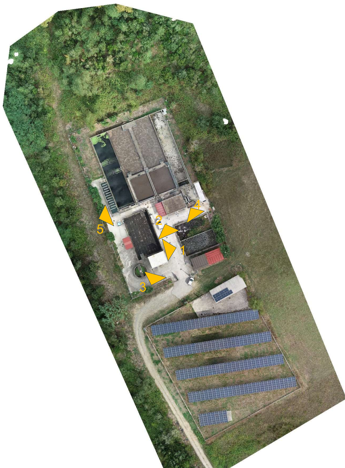
Figura 1: Ortofoto impianto di depurazione di Vallo della Lucania
