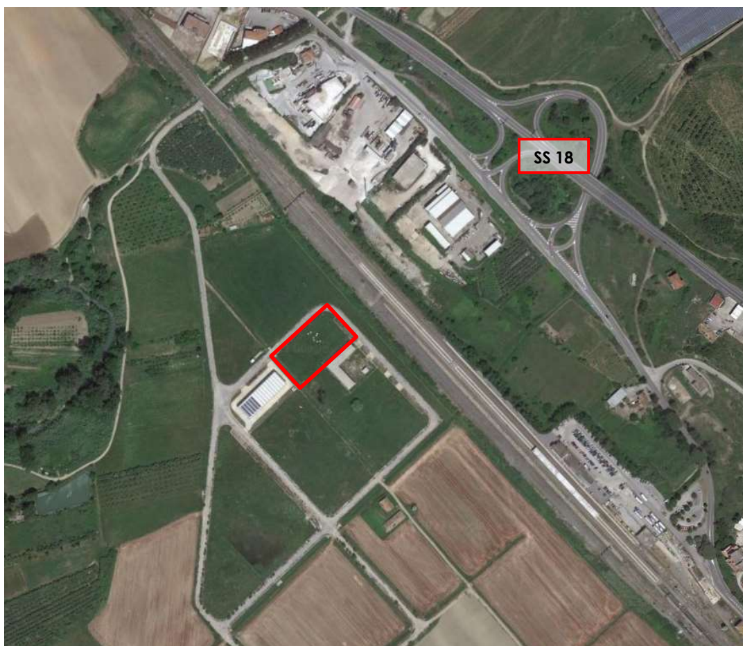
Figura 2: Inquadramento aerofotogrammetrico dell'area del futuro trattamento di essiccazione fanghi (in rosso) e della strada SS 18
