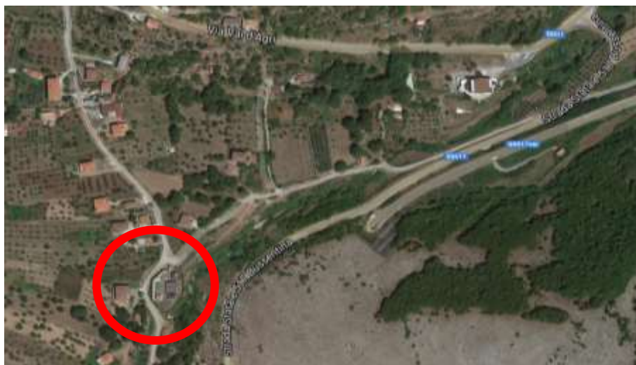
Foto 01 - Impianto di depurazione esistente (vista d'insieme)
