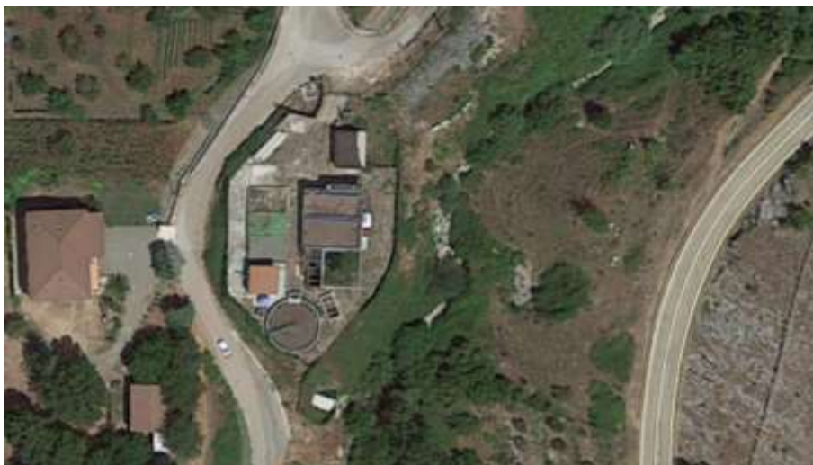
Foto 02 - Impianto di depurazione esistente (vista d'insieme)
