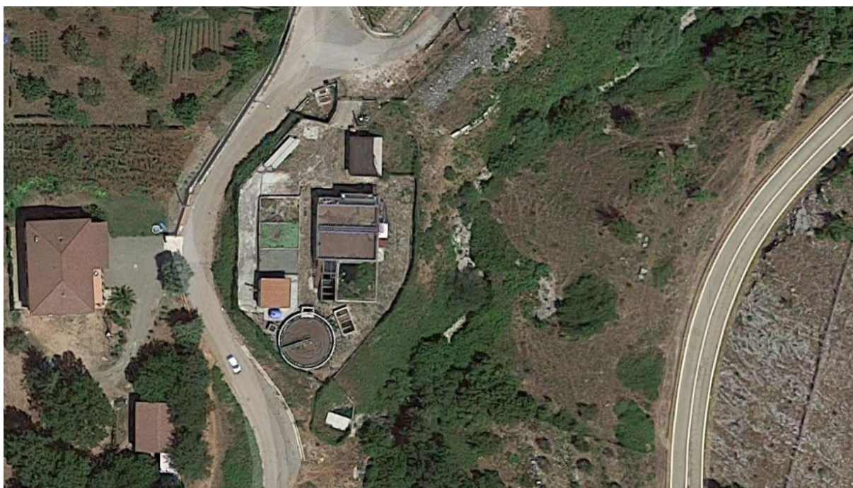
Foto 02 - Impianto di depurazione (vista d'insieme)
