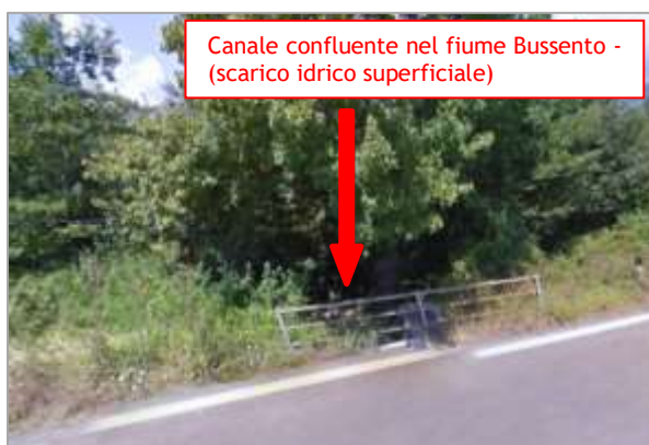
Foto 04 - Area depuratore (canale di scarico effluente depurato)
