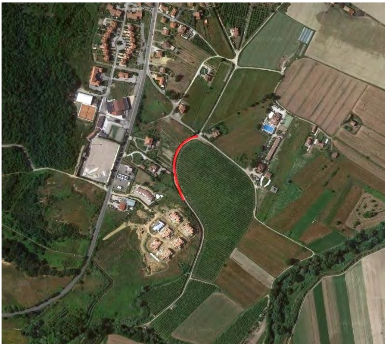
Fig. 38 – Localizzazione intervento su ortofoto, fuori scala.
