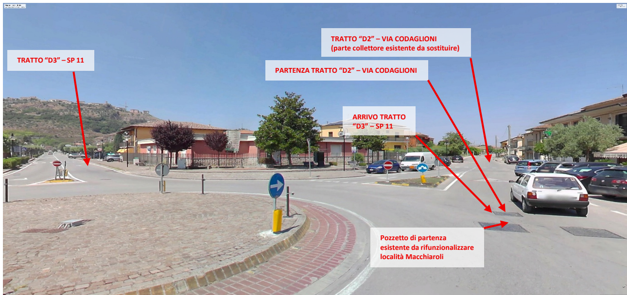
Foto 3 – Vista dell’area Pozzetto di partenza località “Macchiaroli” oggetto d’intervento.
