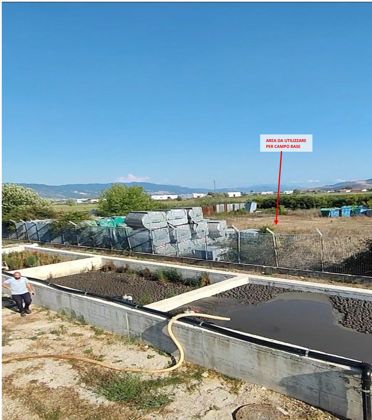
Foto 37 - Vista dell'area ADIACENTE AL DEPURATORE TEGGIANO - AREA CAMPO BASE – Difesa delle Margini.
