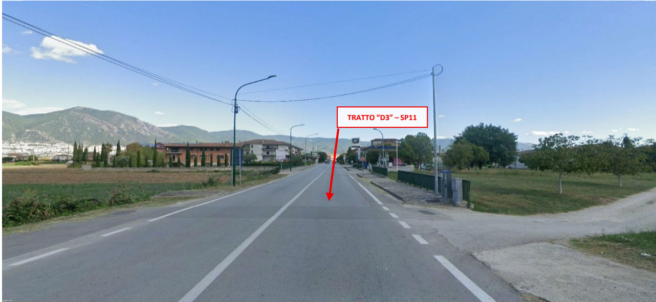
Foto 1 – Vista dell'area TRATTO "D3" (tratto iniziale inizio collettore di progetto) – SP. 11 oggetto d'intervento.
