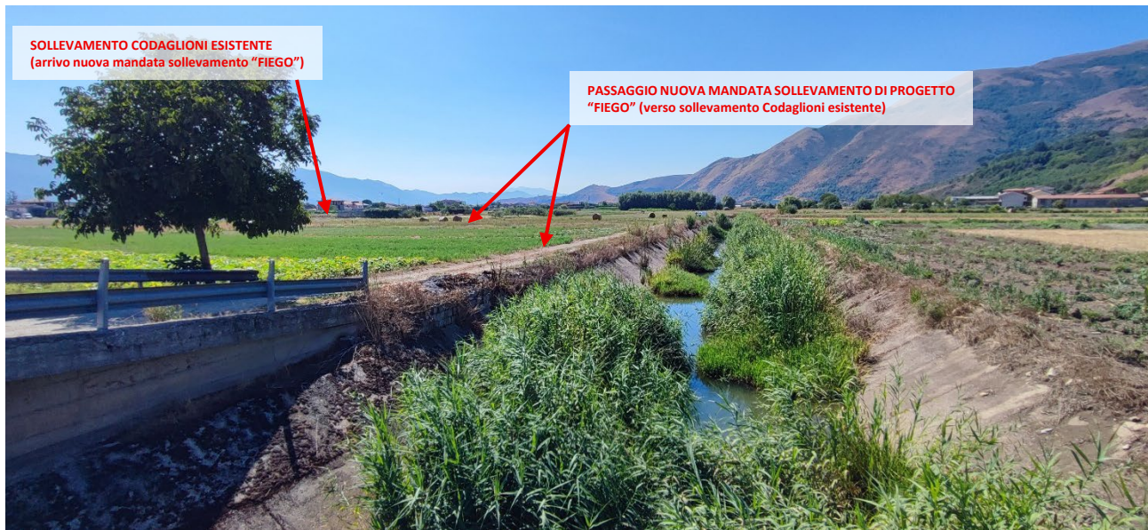
Foto 17 – Vista dell’area realizzazione mandata nuovo sollevamento di progetto “FIEGO” oggetto d’intervento.
