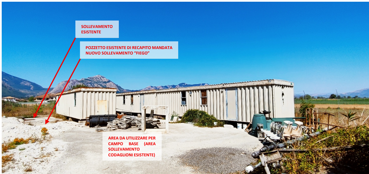
Foto 13 - Vista dell'area SOLLEVAMENTO CODAGLIONI ESISTENTE (area interna) oggetto d'intervento.
