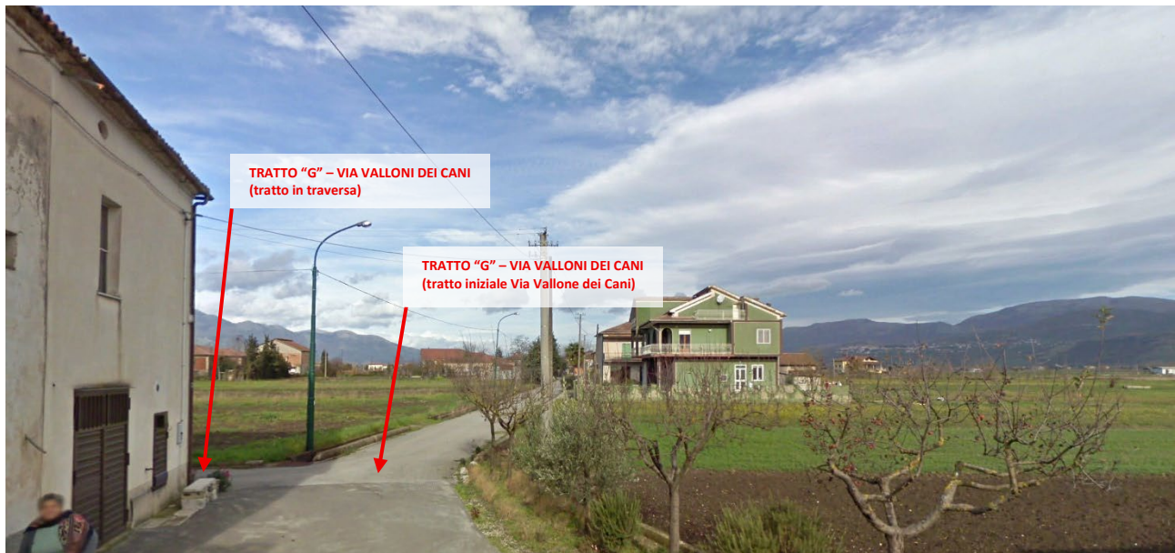
Foto 33 - Vista dell'area TRATTO "G" (tratto iniziale in Via Valloni dei Cani) – Via Valloni dei Cani oggetto d'intervento.
