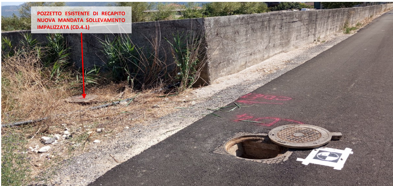
Foto 11 – Vista dell'area pozzetto esistente di recapito (CD.4.1) nuova mandata sollevamento Impalizzata oggetto d'intervento strada da incrocio Impalizzata a sollevamento Codaglionesi esistente.
