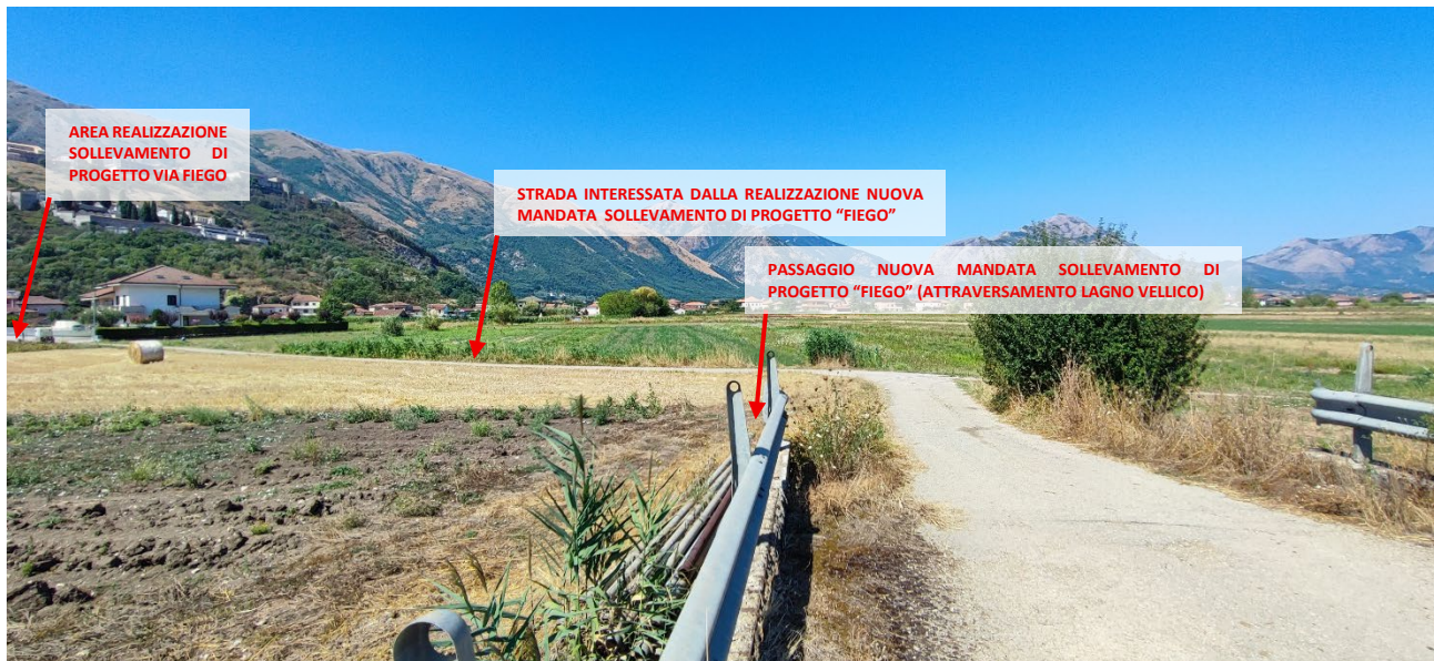
Foto 15 - Vista dell'area realizzazione mandata nuovo sollevamento di progetto "FIEGO" oggetto d'intervento.
