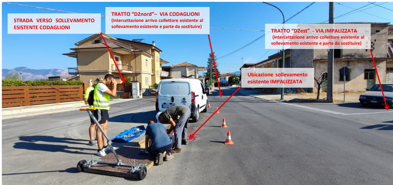
Foto 7 – Vista dell’area rifunzionalizzazione sollevamento IMPALIZZATA (in fase di rilievo) oggetto d’intervento.
