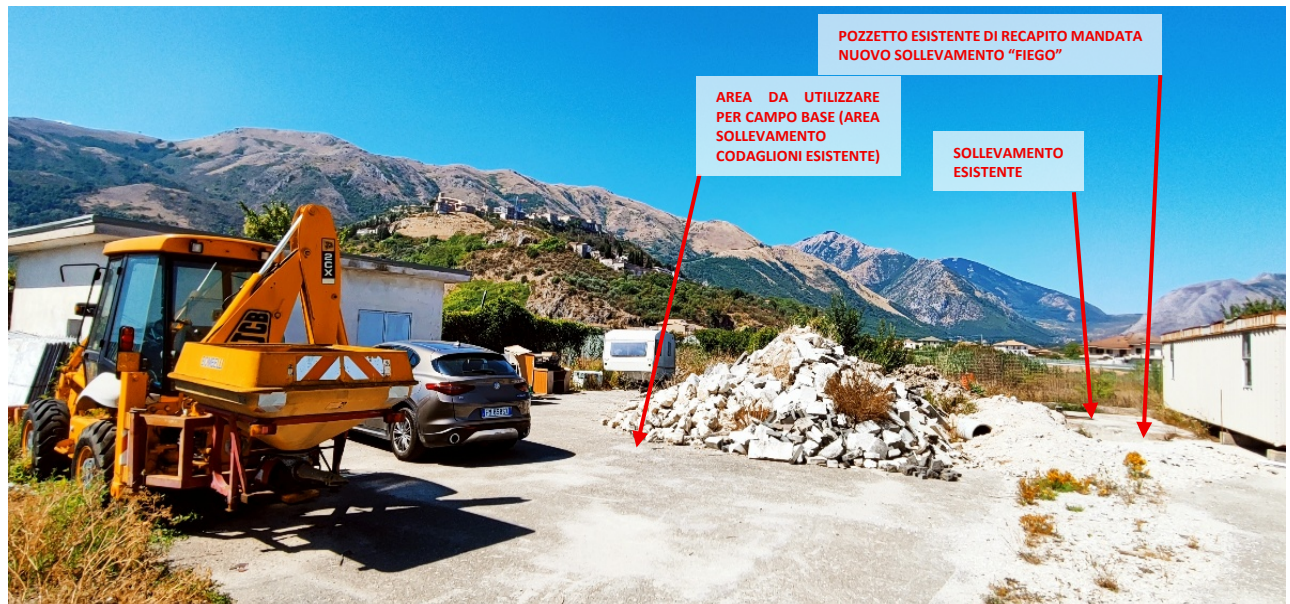
Foto 12 - Vista dell'area SOLLEVAMENTO CODAGLIONI ESISTENTE (area ingresso/interna) oggetto d'intervento.
