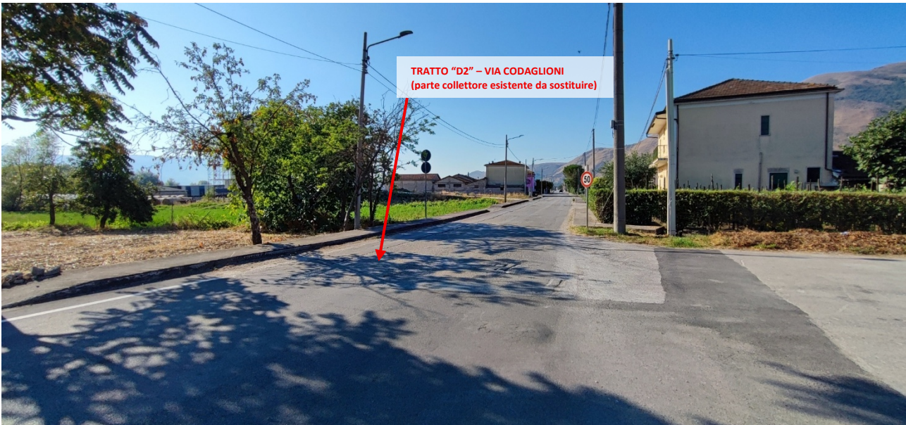
Foto 6 – Vista dell’area TRATTO “D2” (tratto finale - parte collettore esistente da sostituire) – Via Codaglioni oggetto d’intervento.
