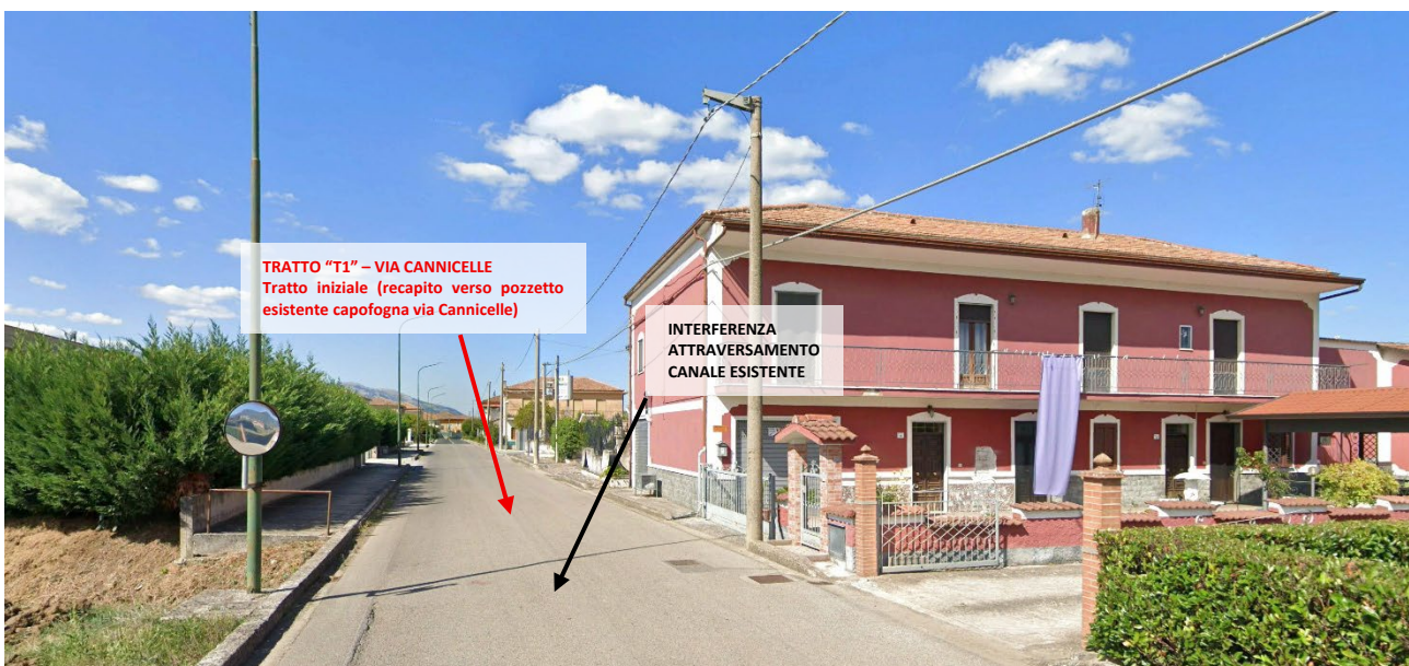
Foto 26 - Vista dell'area TRATTO "T1" Tratto iniziale (recapito verso pozzetto esistente capofogna via Cannicelle)
