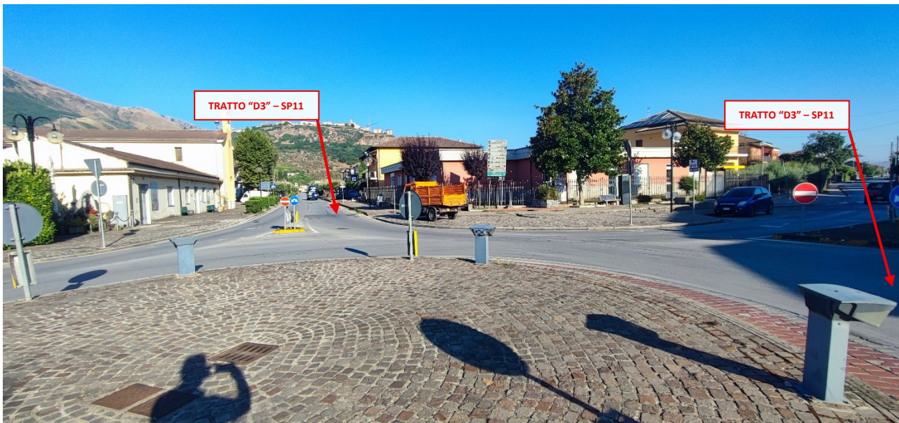
Foto 2 – Vista dell'area TRATTO "D3" (tratto finale collettore di progetto verso pozzetto di partenza)
