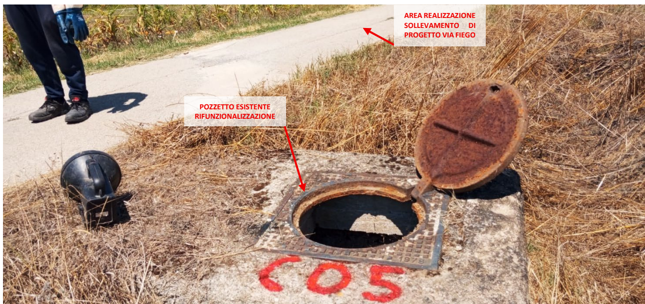
Foto 14 - Vista dell'area (in fase di rilievo) realizzazione nuovo sollevamento di progetto VIA FIEGO oggetto d'intervento.
