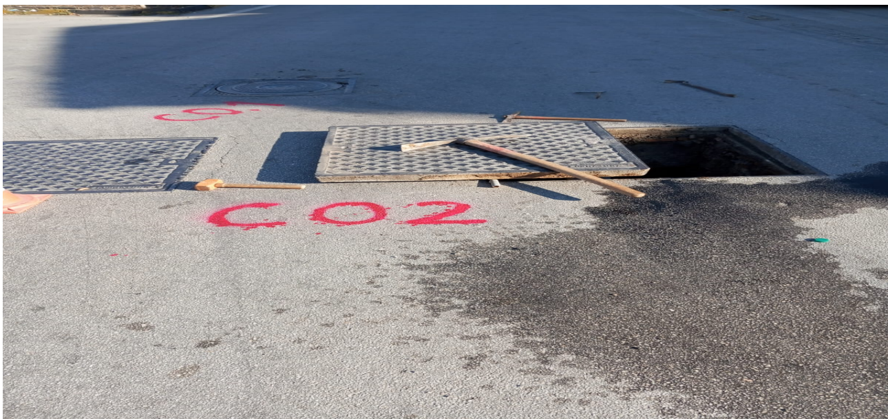
Foto 4 – Vista dell’area Pozzetto di partenza (in fase di rilievo) località “Macchiaroli” oggetto d’interven
