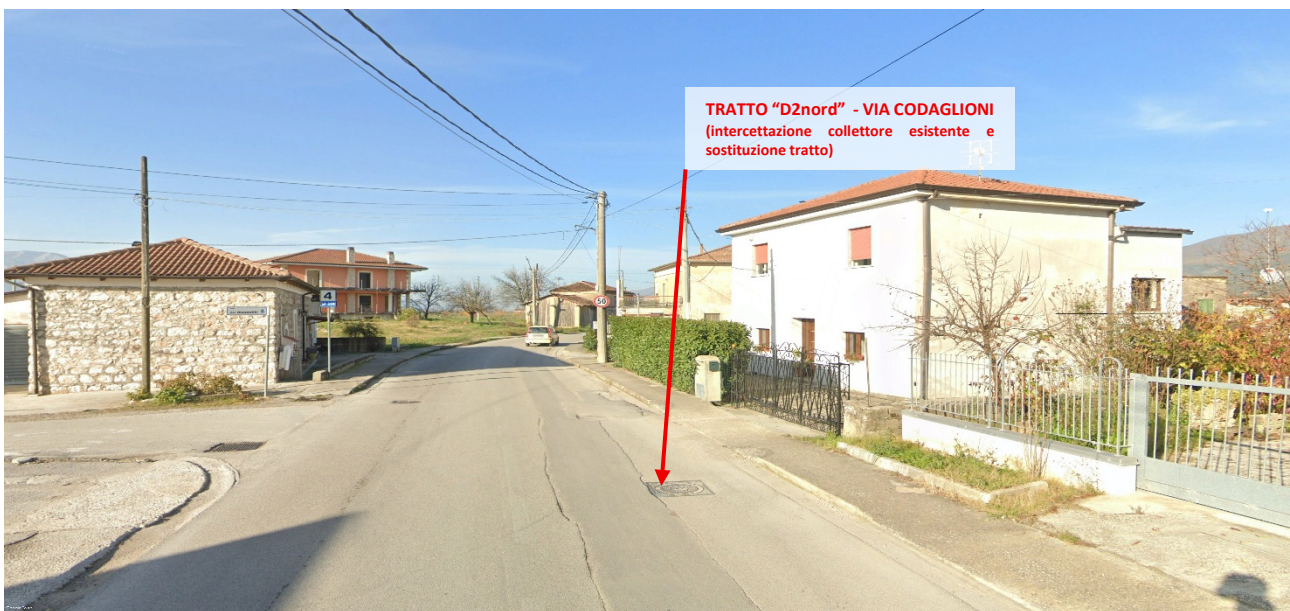
Foto 10 – Vista dell’area fine tratto “D2nord” oggetto d’intervento Via Codaglioni zona industriale.
