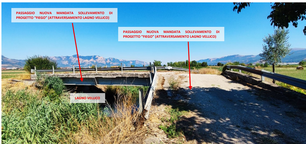
Foto 16 – Vista dell'area attraversamento LAGNO VELLICO nuova mandata sollevamento di progetto VIA FIEGO I
