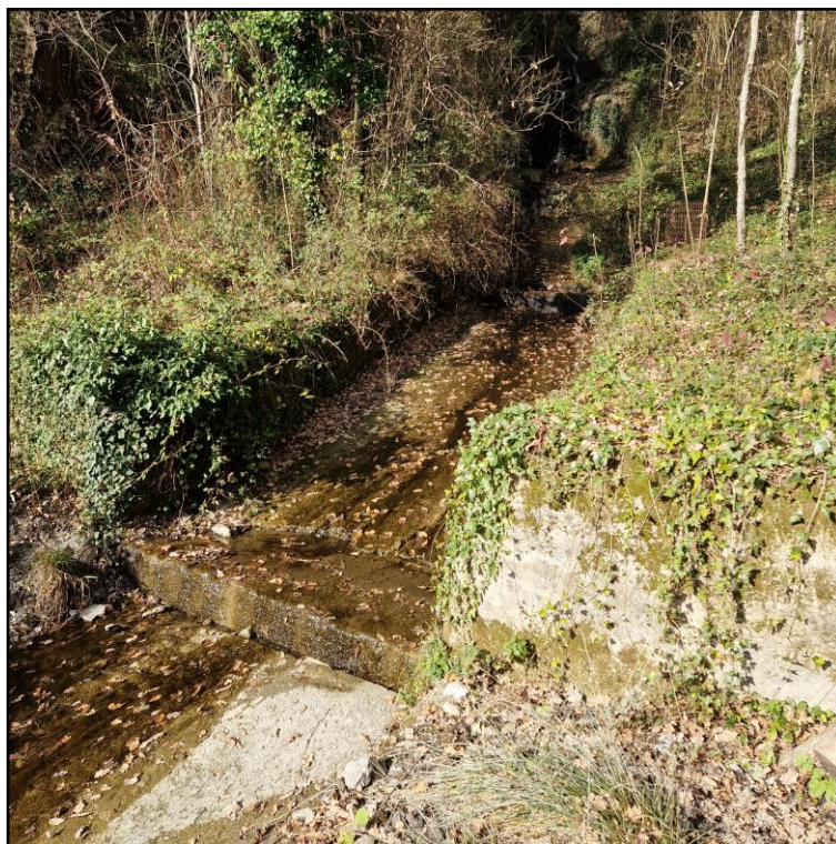
Foto n. 3 – tratto del torrente Carbonaro sistemato in prossimità dell'attraversamento fognario
