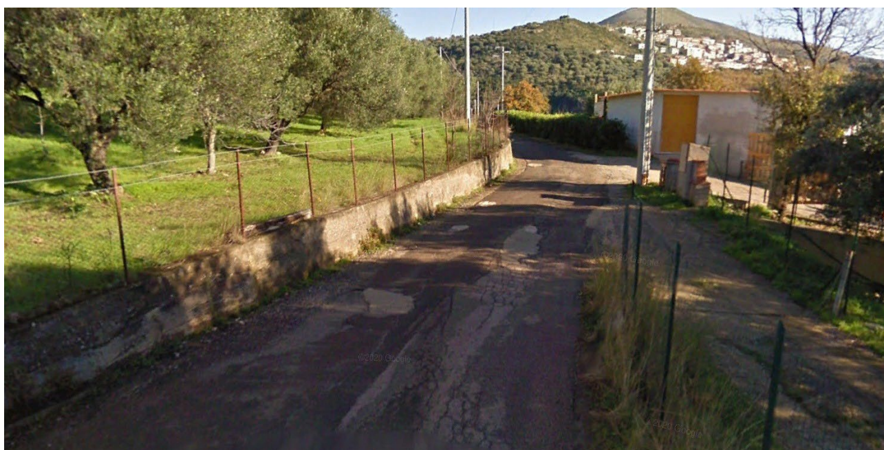
UR 9 vista da sud ovest
