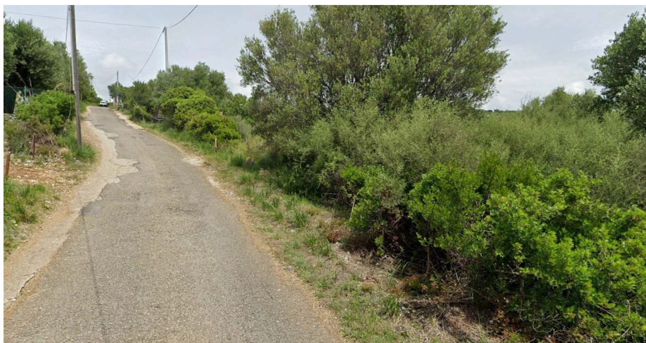
UR 6 vista da sud ovest
