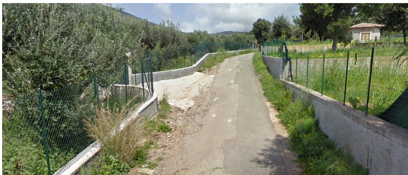
UR 5 vista da sud ovest
