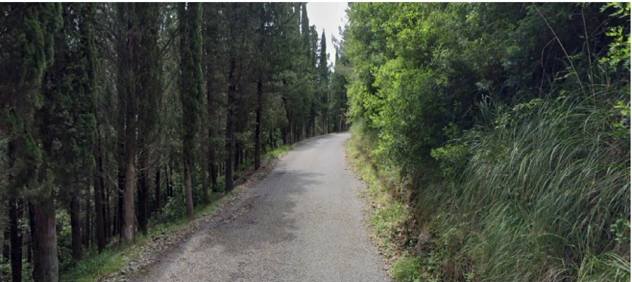
UR 2 VISTA DA NORD-EST
