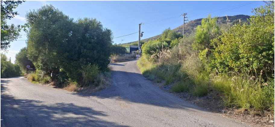
UR 12 VISTA DA SUD-EST
