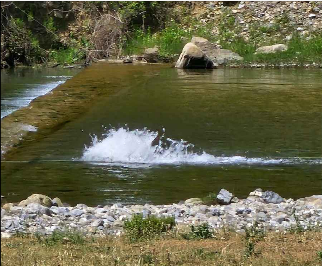
Dettaglio sulla perdita della condotta esistente
