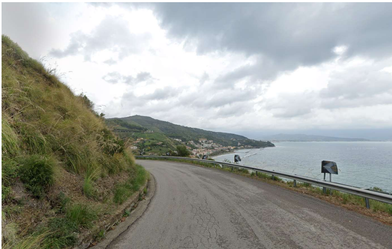
Foto lungo il percorso della condotta.
