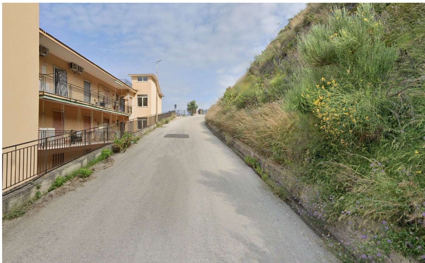
Foto lungo il percorso della condotta.
