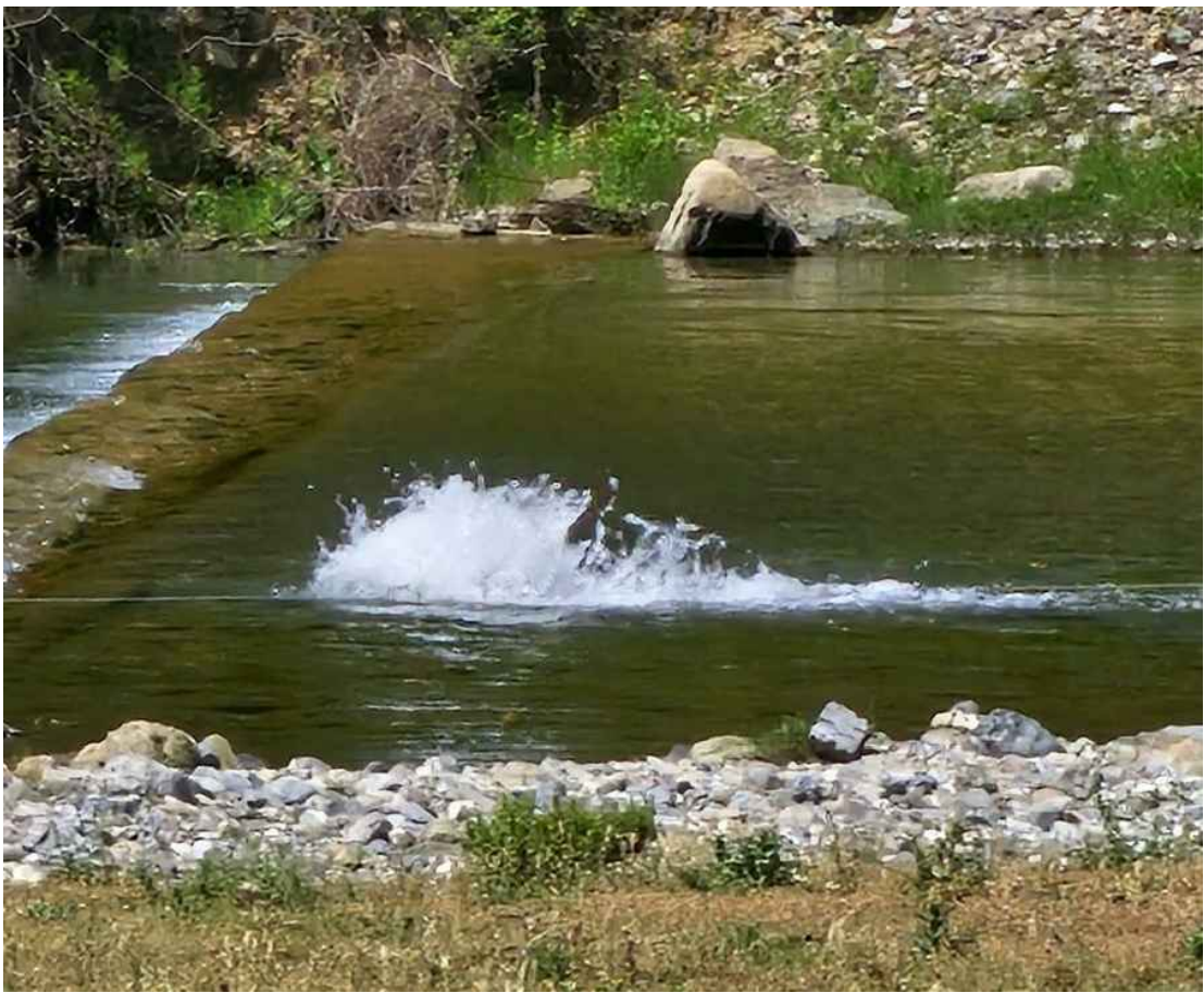
Dettaglio sulla perdita della condotta esistente
