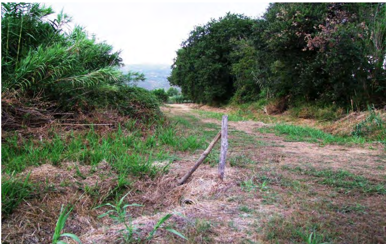
Fig. 35 – Ripresa dal punto n. 5 in planimetria verso il punto n. 6 (Fig. 32) ubicazione del tratto di condotta, vista da ovest.
