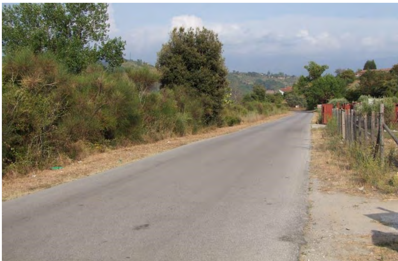
Fig. 70 – Ripresa dal punto n.1 vista dei punti n.2 e 3 in planimetria (Fig. 67), vista da ovest.
