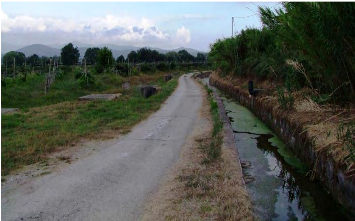
Fig. 41 – Ripresa dal punto n. 3 in planimetria verso i punti n. 2-1 (Fig. 37) ubicazione del tratto di condotta, vista da nord.
