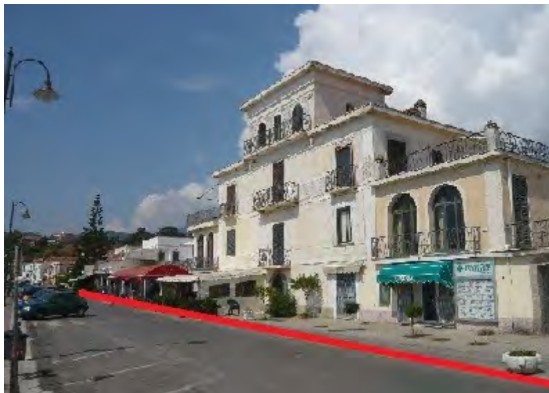
Fig. 5 – Parte del Lungomare Speranza, in rosso indicazione del tratto fognario, vista da Est.
