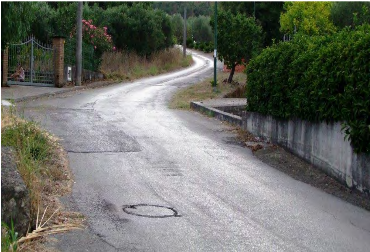
Fig. 66 - Fornari I - Ripresa dal punto n.1 e vista del n. 2 e 3, della planimetria (Fig. 58), vista da nord.
