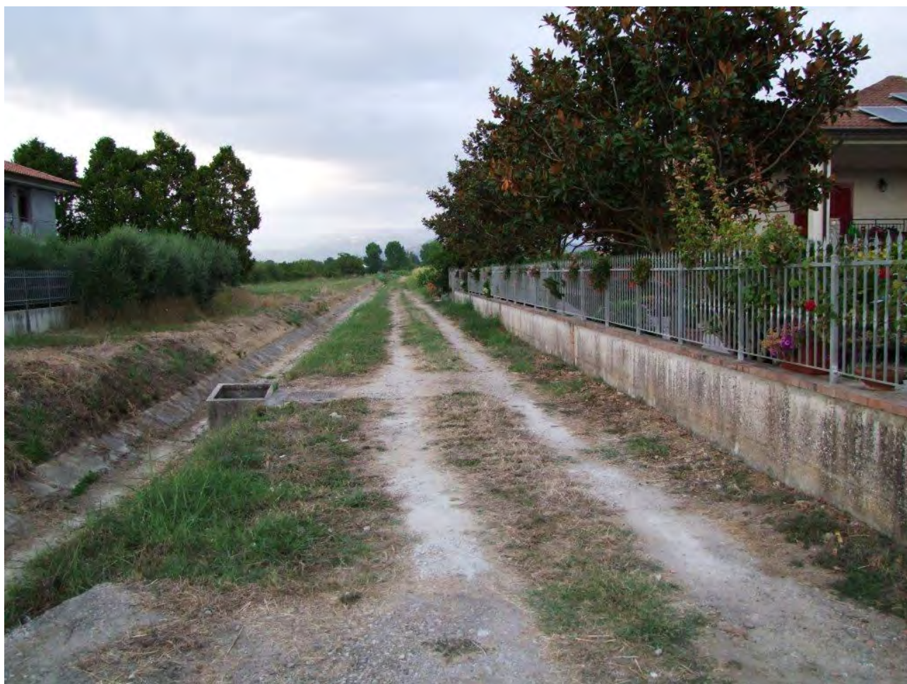
Fig. 24 – Ripresa dal punto n. 4 in planimetria (Fig.21) ubicazione del tratto di condotta, vista da sud.
