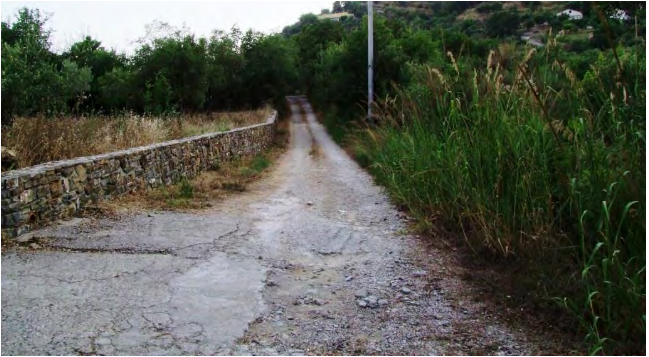
Fig. 52 - San Giorgio II – Ripresa dal punto n.14 e vista punto n. 15, della planimetria (Fig. 47), vista da nord.
