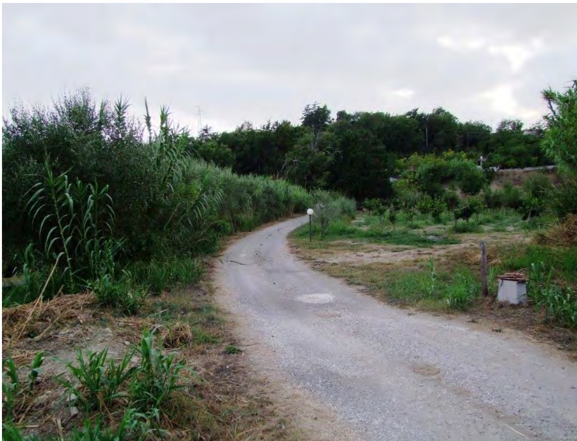
Fig. 36 – Ripresa dal punto n. 4 in planimetria verso il punto n. 3 (Fig. 22) ubicazione del tratto di condotta, vista da est.
