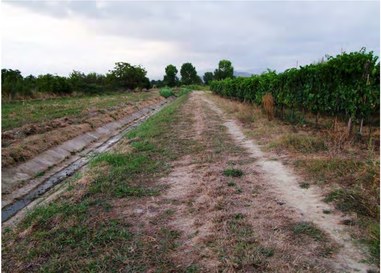
Fig. 25 – Ripresa tra il punto n. 4 e il n. 3 in planimetria (Fig.21) ubicazione del tratto di condotta, vista da sud.
