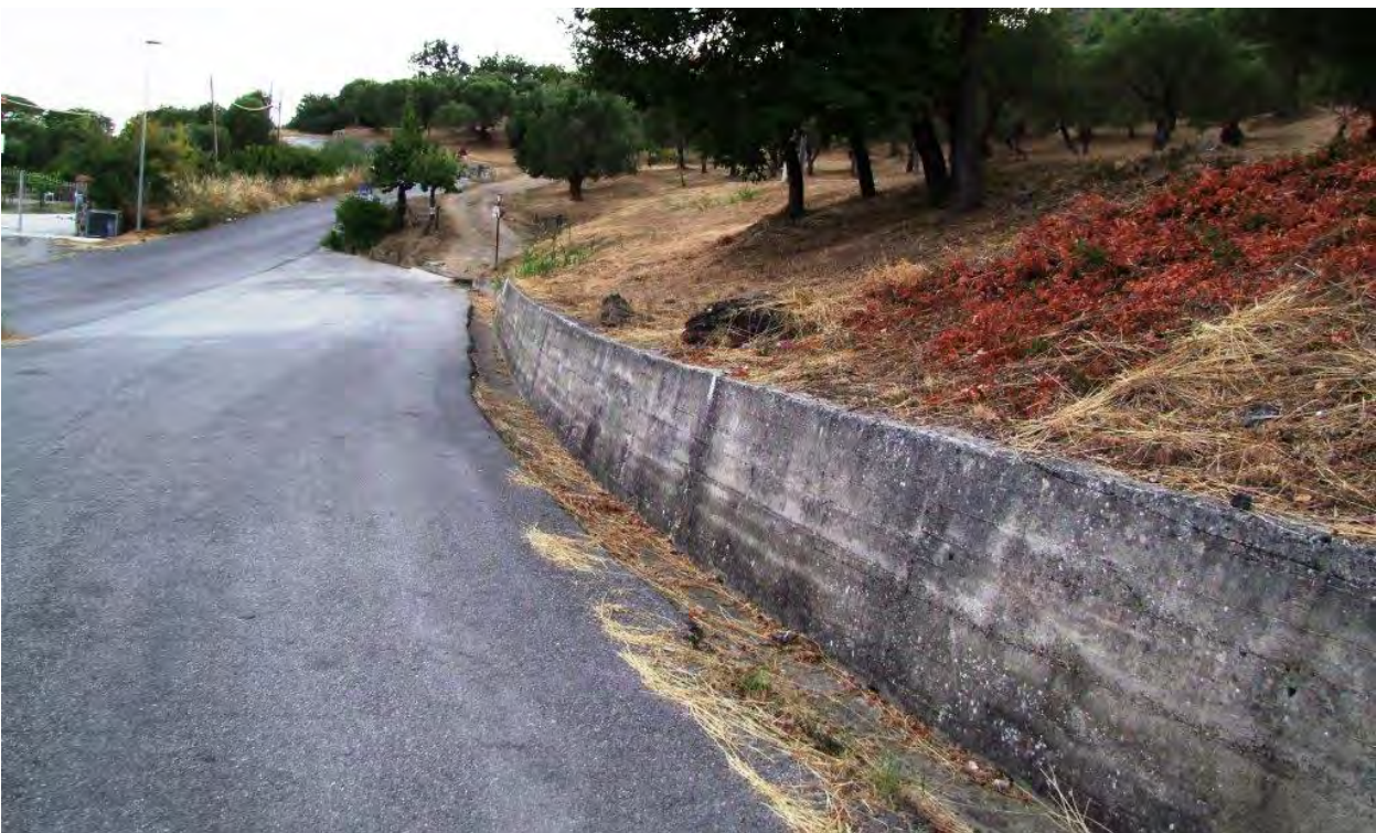
Fig. 51 - San Giorgio I – Ripresa dal punto n.14 e vista punto n. 15, della planimetria (Fig. 47), vista da nord.
