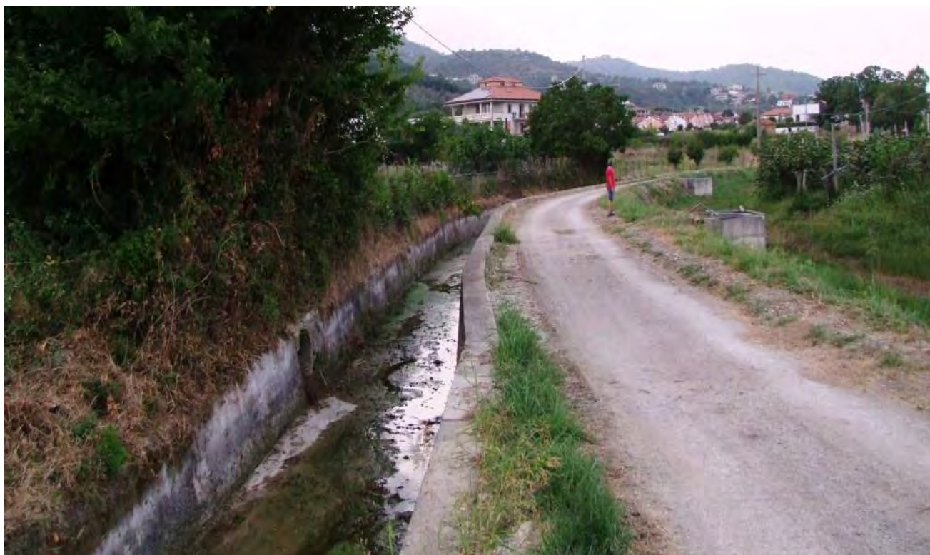
Fig. 42 – Ripresa dal punto n. 1 in planimetria verso i punti n. 2-3 (Fig. 37) ubicazione del tratto di condotta, vista da est.
