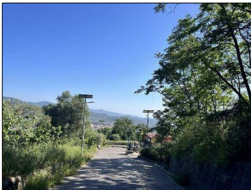
Figura 4 - strada oggetto dell'intervento UUR 1 e 4 – vista da NE
