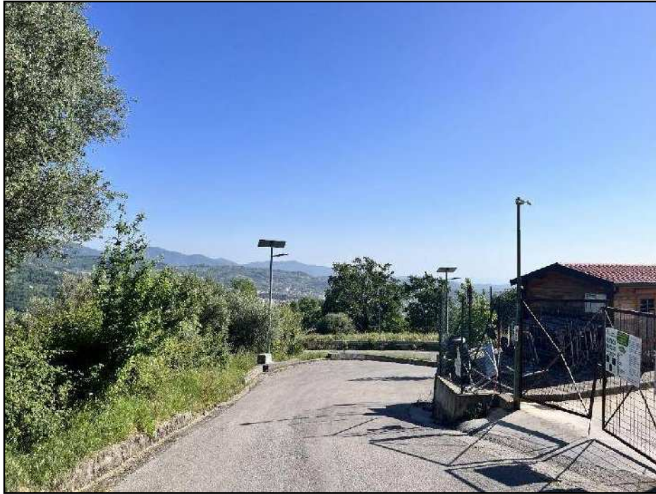
Figura 5 - UURR 1 e 4 vista da N
