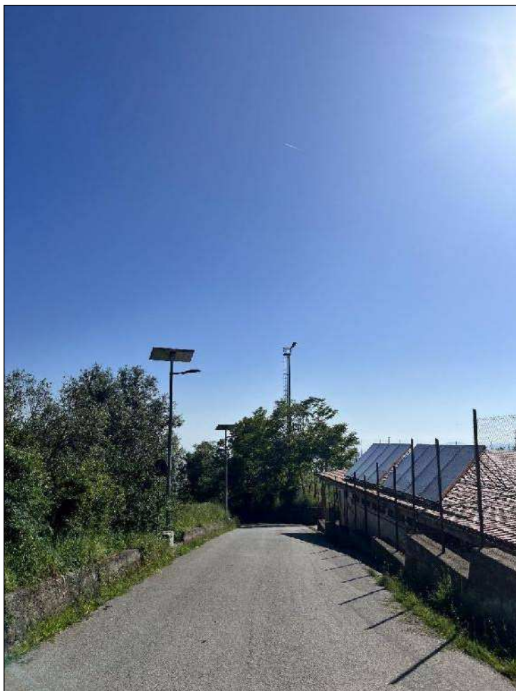
Figura 1 - strada oggetto dell'intervento - UURR 1 e 4 vista da NO
