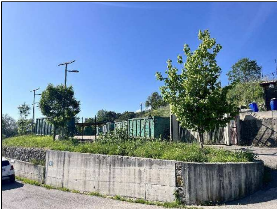
Figura 6 - UR 1 vista da E
