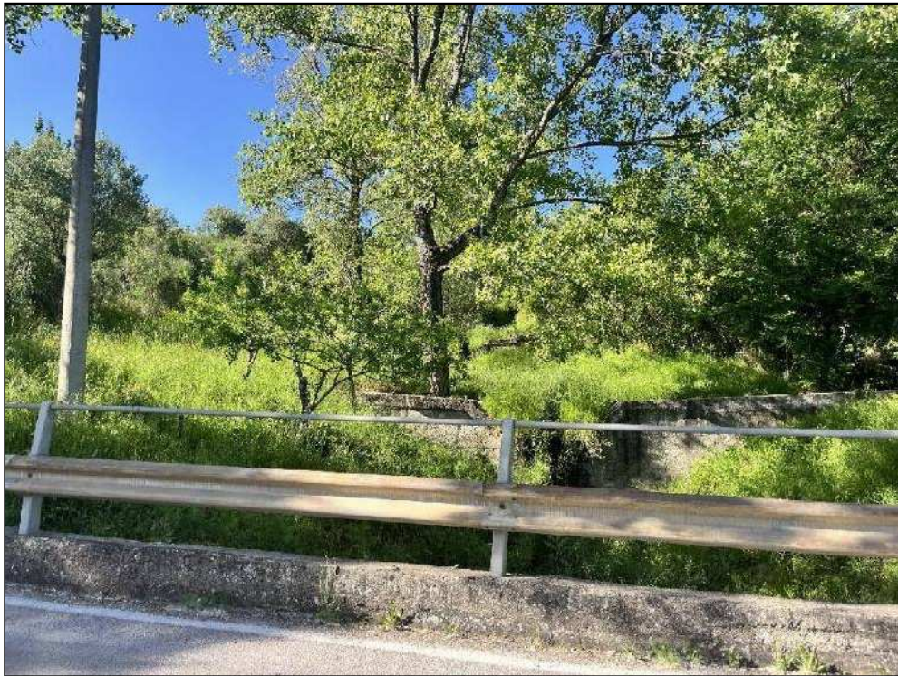
Figura 15 - UR 6 vista da SE
