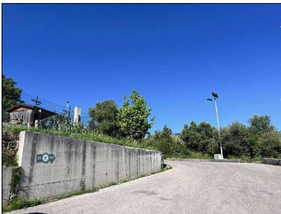
Figura 8 – UURR 1 e 4 vista da SO
